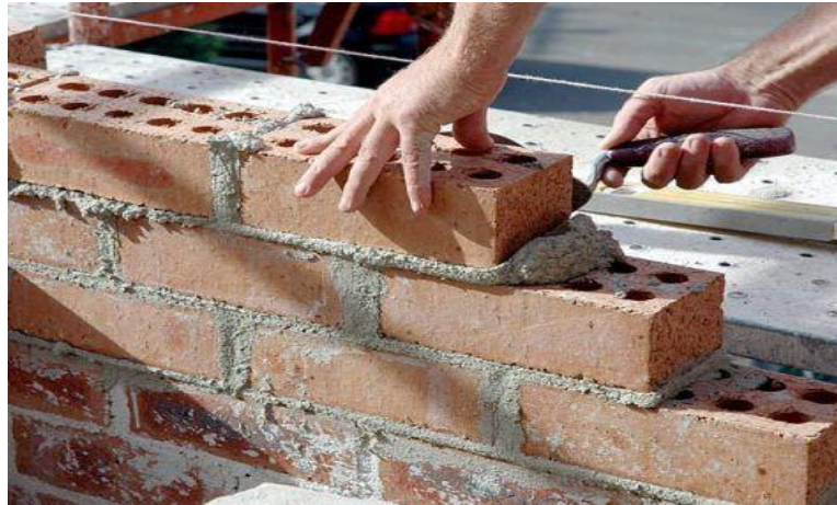
Figura 04. Imagen de muro
