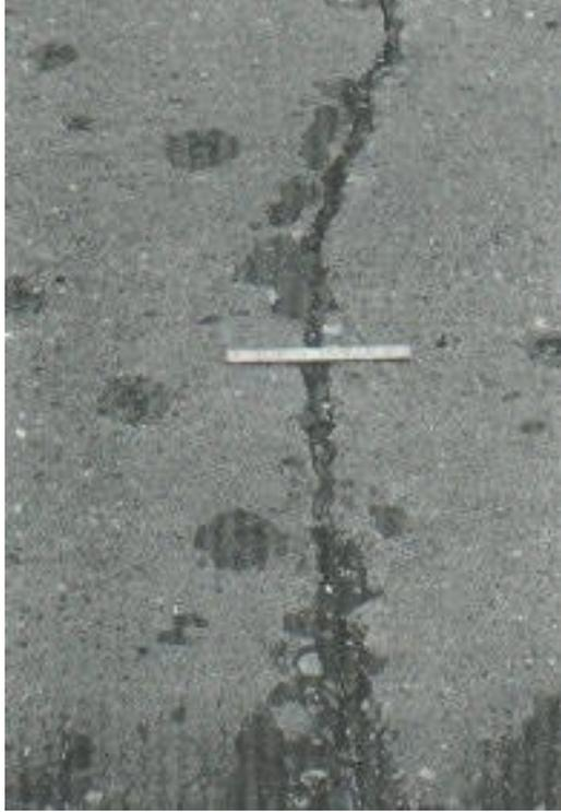
*Figura 28:* Falla de grietas lineales.
