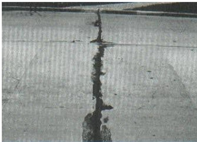
*Figura 26: Falla de daño del sello de junta*
