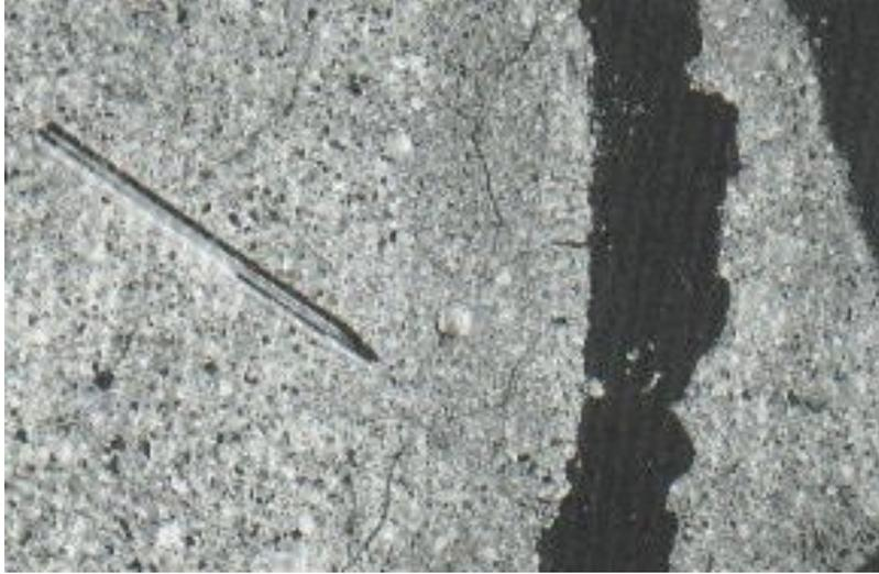
*Figura 24:* Falla de Grieta de Durabilidad
