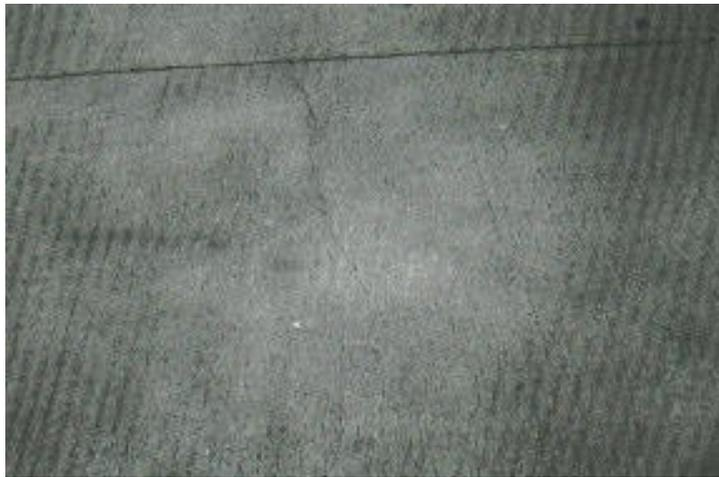
*Figura 37: Falla de grietas de retracción*
