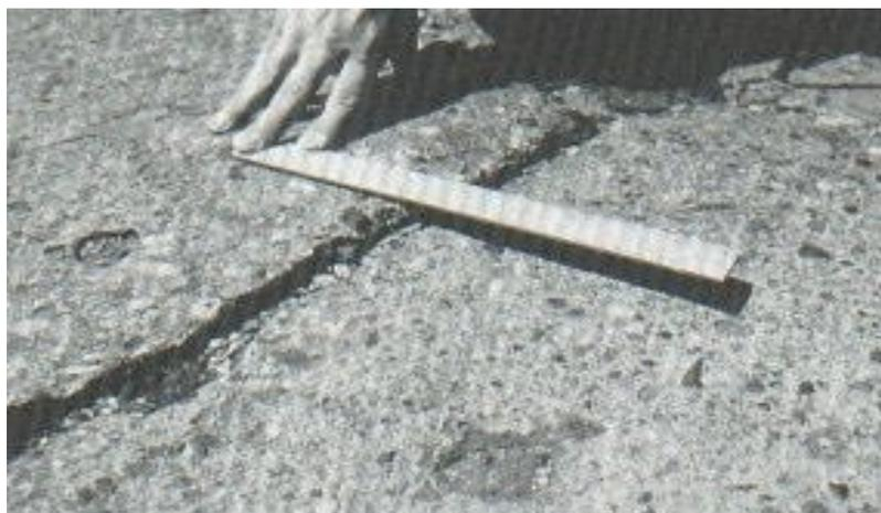
*Figura 25:* Falla de Escala
