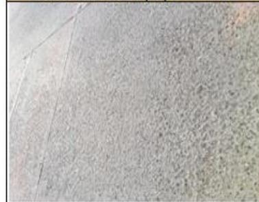
Figura 65: Patología del pavimento rígido falla 31 – Pulimento de Agregado – UM - 02
