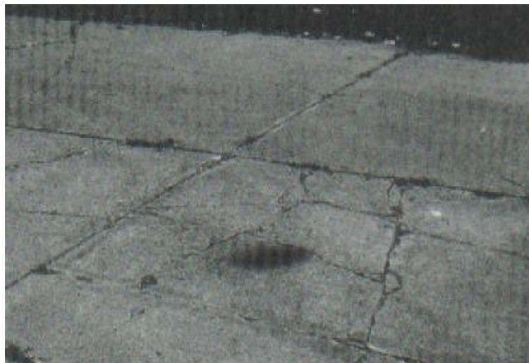
Figura 23: Falla de Losa Dividida
