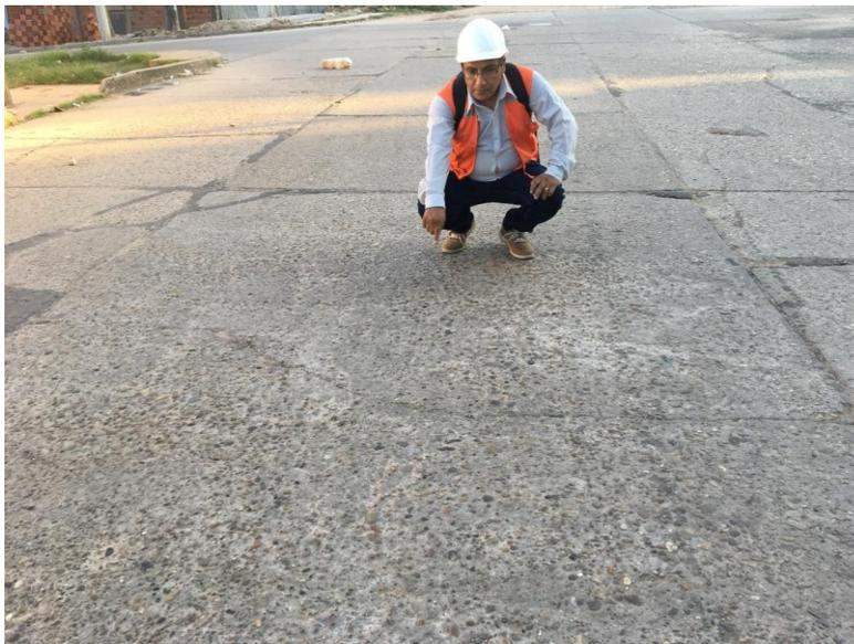
Figura 31: Falla de pulimento de agregados
