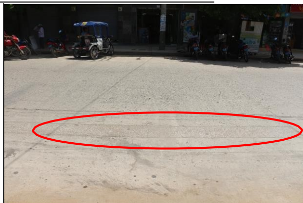
Figura 53. Patología de parche grande con nivel de severidad baja; en la cuadra 6 del Jr. Ucayali, distrito de Callería.
