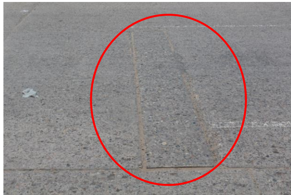
Figura 49. Patología de parche grande, con nivel de severidad baya, en la cuadra 5 del Jr. Ucayali, distrito de Calleria.
