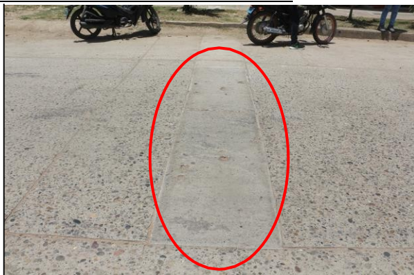
Figura 33. Patología de parche grande con nivel de severidad baja; en la cuadra 1 del Jr. Ucayali, distrito de Calleria.
