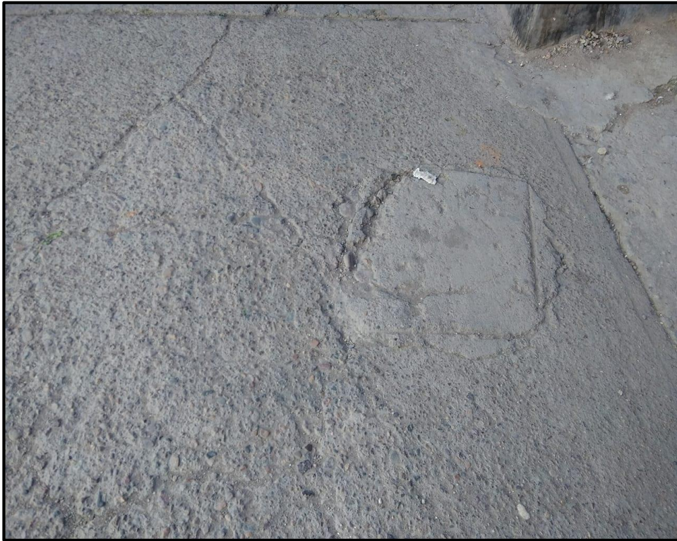
Figura 5. Parche pequeño y pulimiento de agregado Fuente: propia 2018
