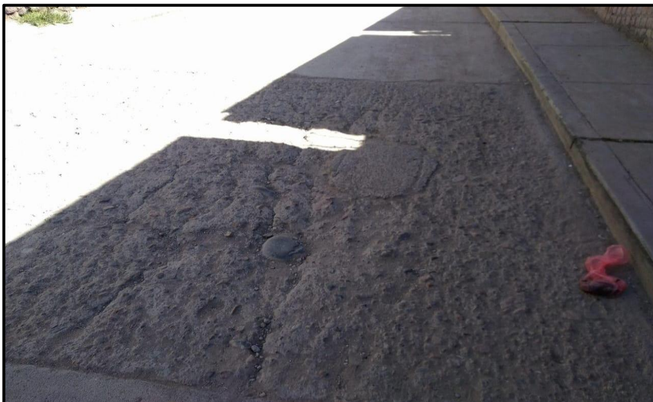
Figura 6. Pulimiento de agregado y punzonamiento Fuente: propia 2018
