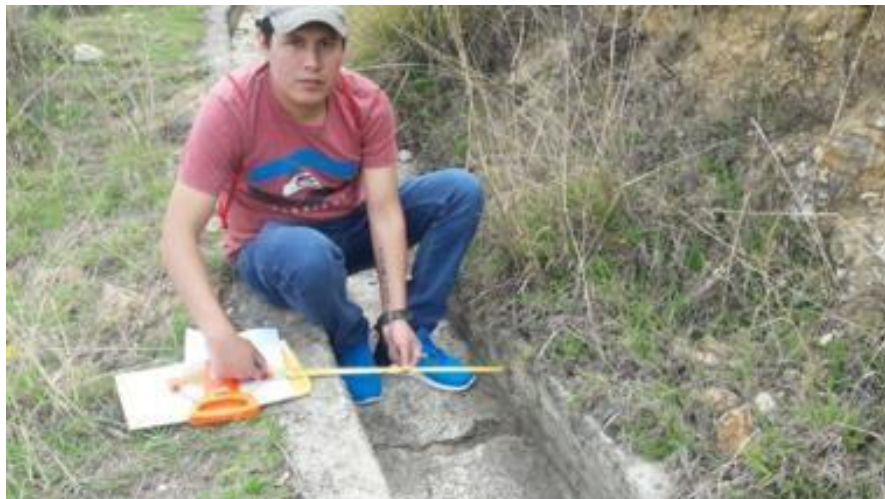
Fotografía 2. Vista de la unidad muestral 02 del canal de riego
