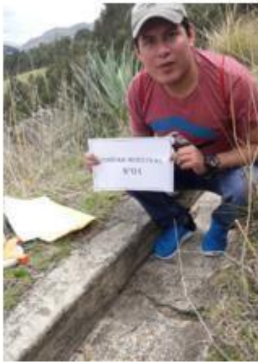
Fotografía 1. Vista de la unidad muestral 01 del canal de riego
