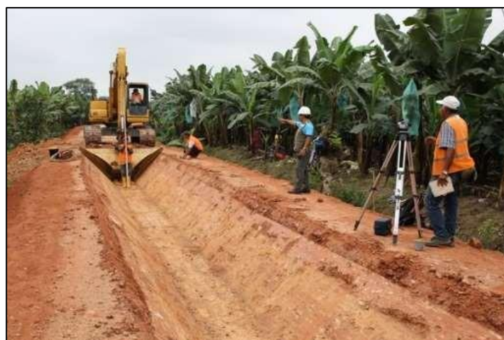
Figura 8. Formación de talud
