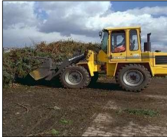
Figura 6. Despalme y desmonte
