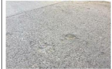
Figura 08. Patología del Pulimento de Agregado de la Unidad de Muestra 1
