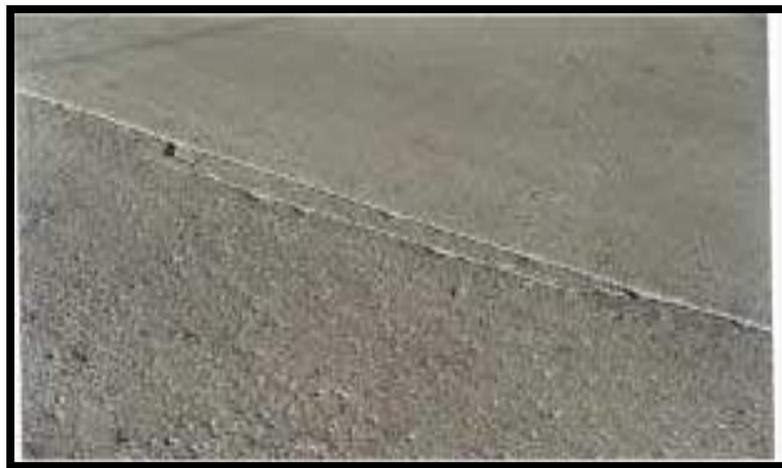
*Figura 23: Fisura por mal comportamiento de junta*
