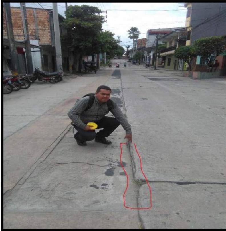
**Figura 113:** Se observa desnivel de carril de alta severidad de la calle cesar calvo de Araujo 6ta cdra.
