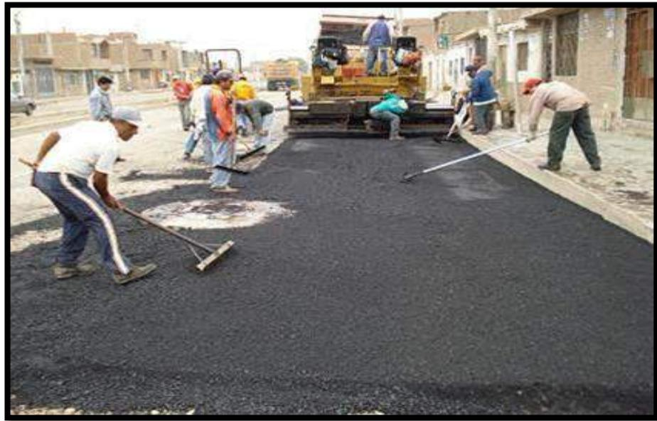
*Figura 3:* Pavimento Flexible
