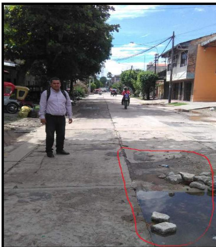
**Figura 124:** Se observa levantamiento de losa en la calle Cesar Calvo de Araujo 8va cuadra
