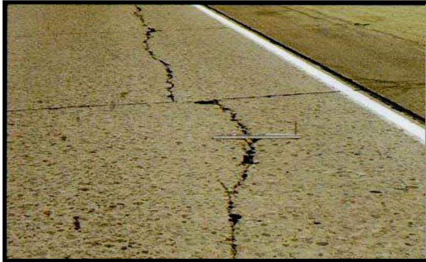
*Figura 9:* Fisura Longitudinal
