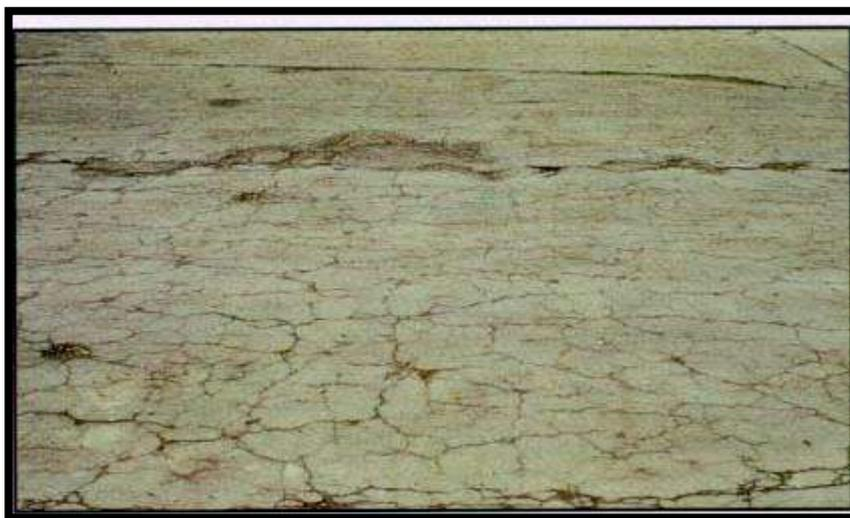
*Figura 12:* Fisura en Bloque
