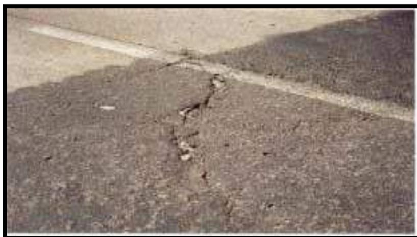
*Figura 13: Fisuras Inducidas*
