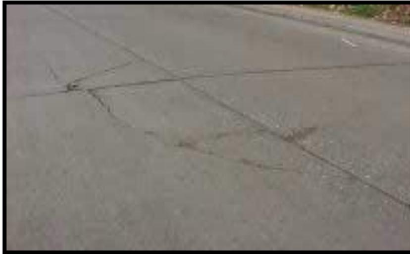
*Figura 10:* Fisura de Esquina
