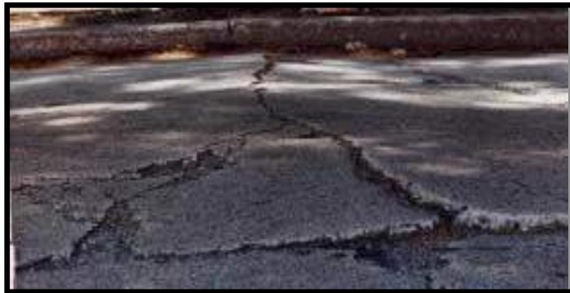
*Figura 14:* Levantamiento de Losas
