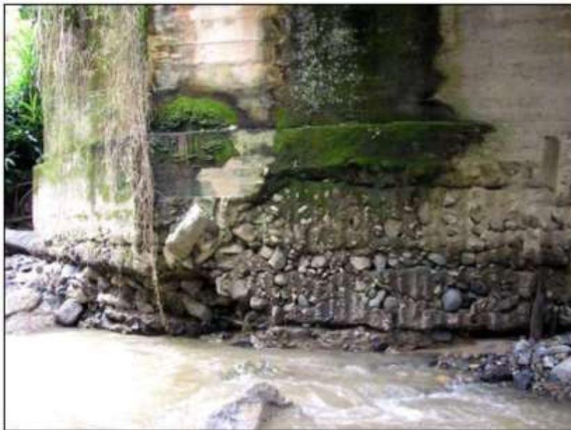
**Grafico 07:** Erosión causada por el agua y otros materiales abrasivos
