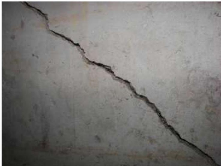
**Grafico 08:** Fisura en muro estructural no mayor a 2mm
