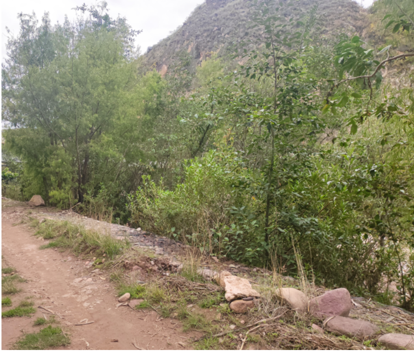
Figura 5.3: Vista de gavión.
