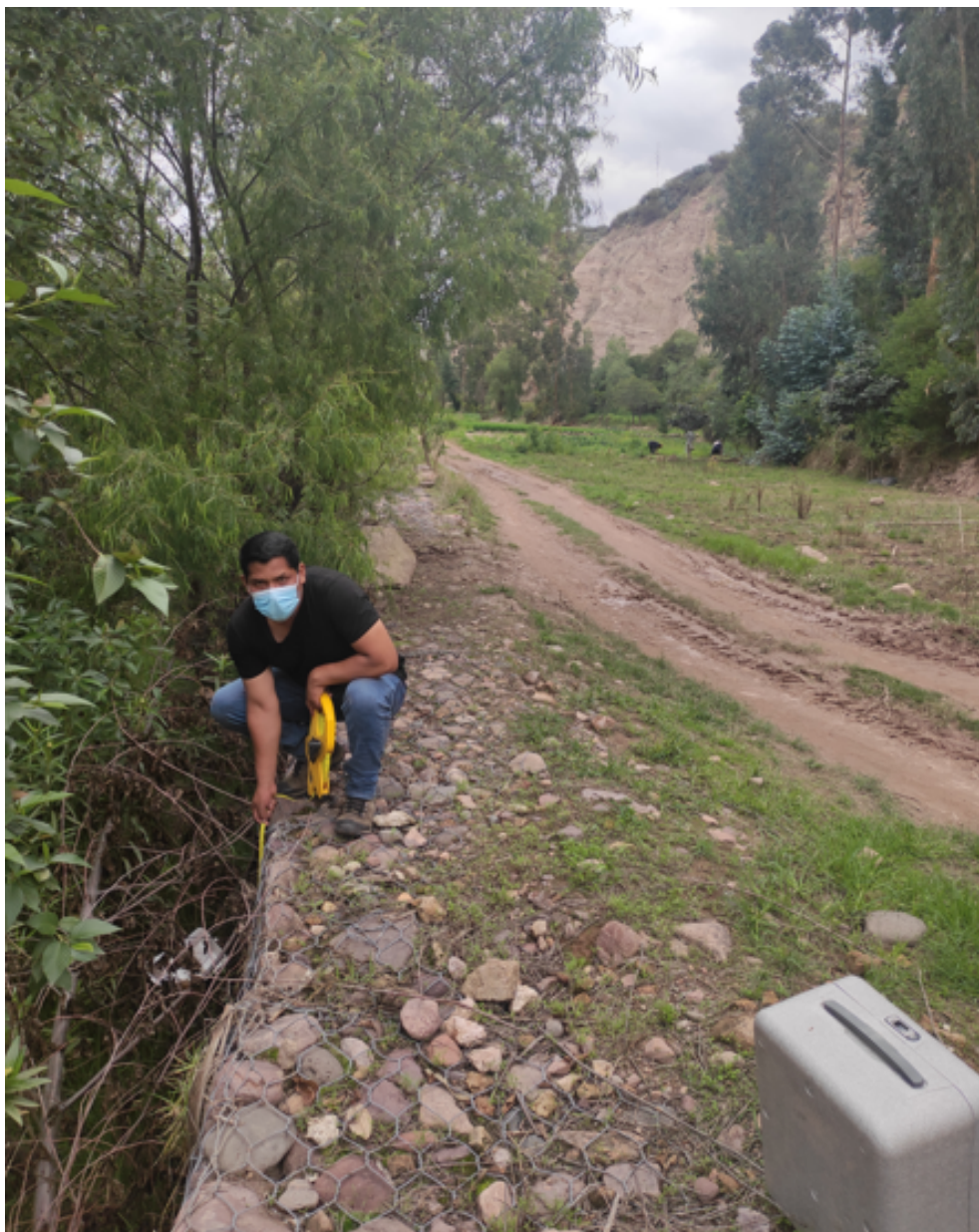
Figura 5.5: Medición de la altura de gavión.
