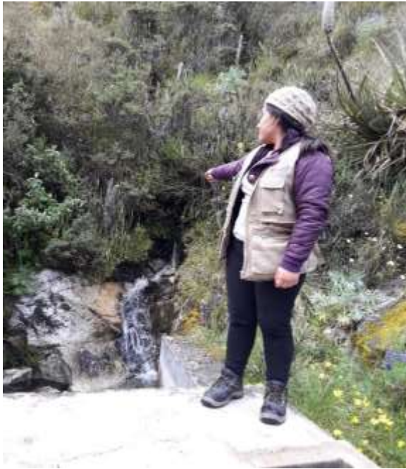
Gráfico 19: Cámara de captación del del Caserío Paragón, Distrito de Pampas, Distrito de Pampas, Provincia de Pallasca, Departamento de Ancash-2019.
