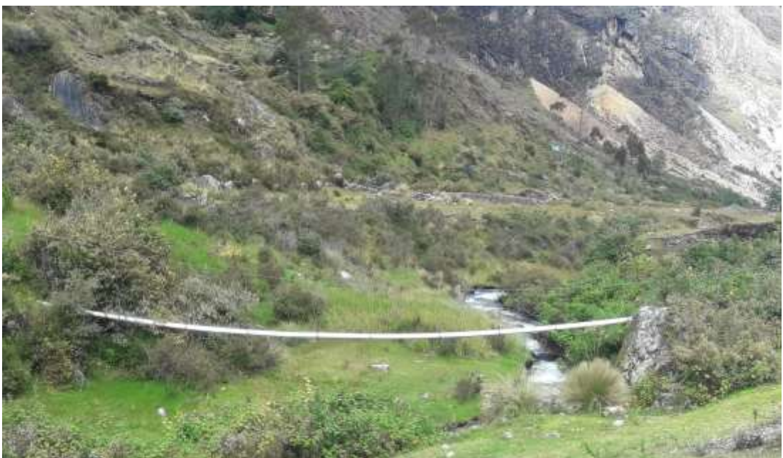
Gráfico 20: La Línea de Conducción del Caserío Paragón, Distrito de Pampas, Provincia de Pallasca, Departamento de Ancash-2019.
