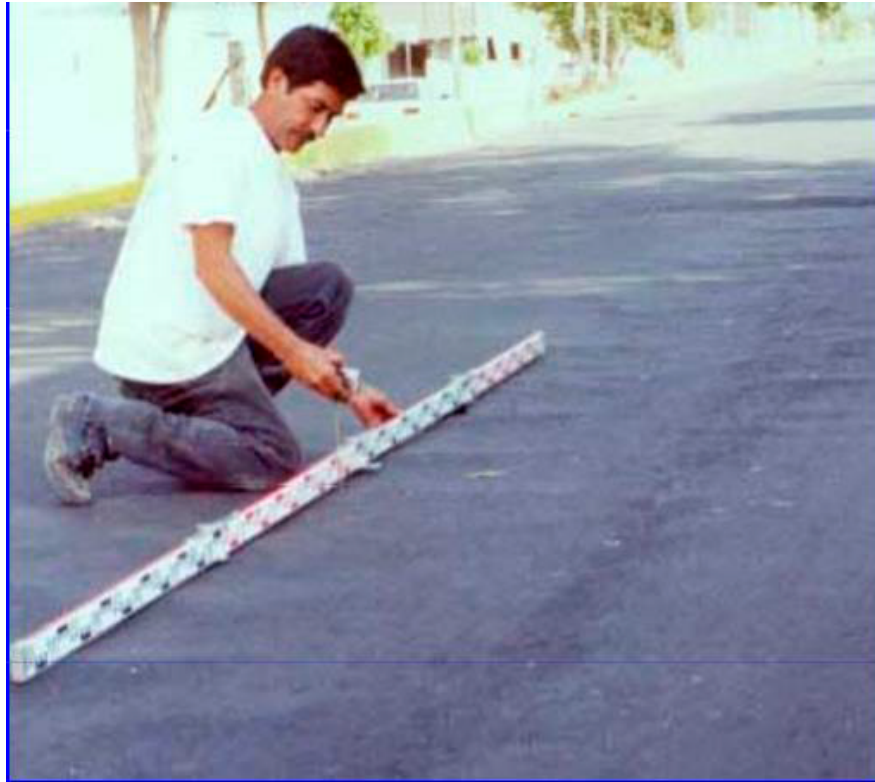
Figura 2.13: Patología tipo Corrugaciones.
