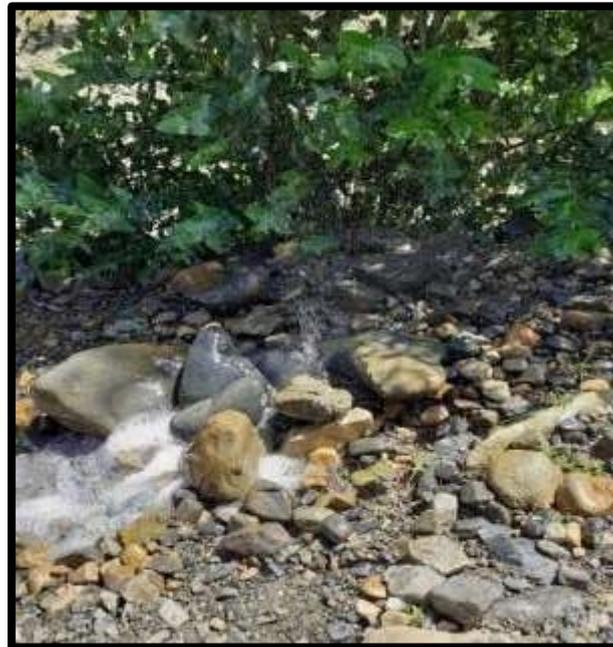
Figura 23: Purga de aire y fuga de agua.
