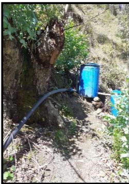
**Figura 18:** Tubería expuesta
