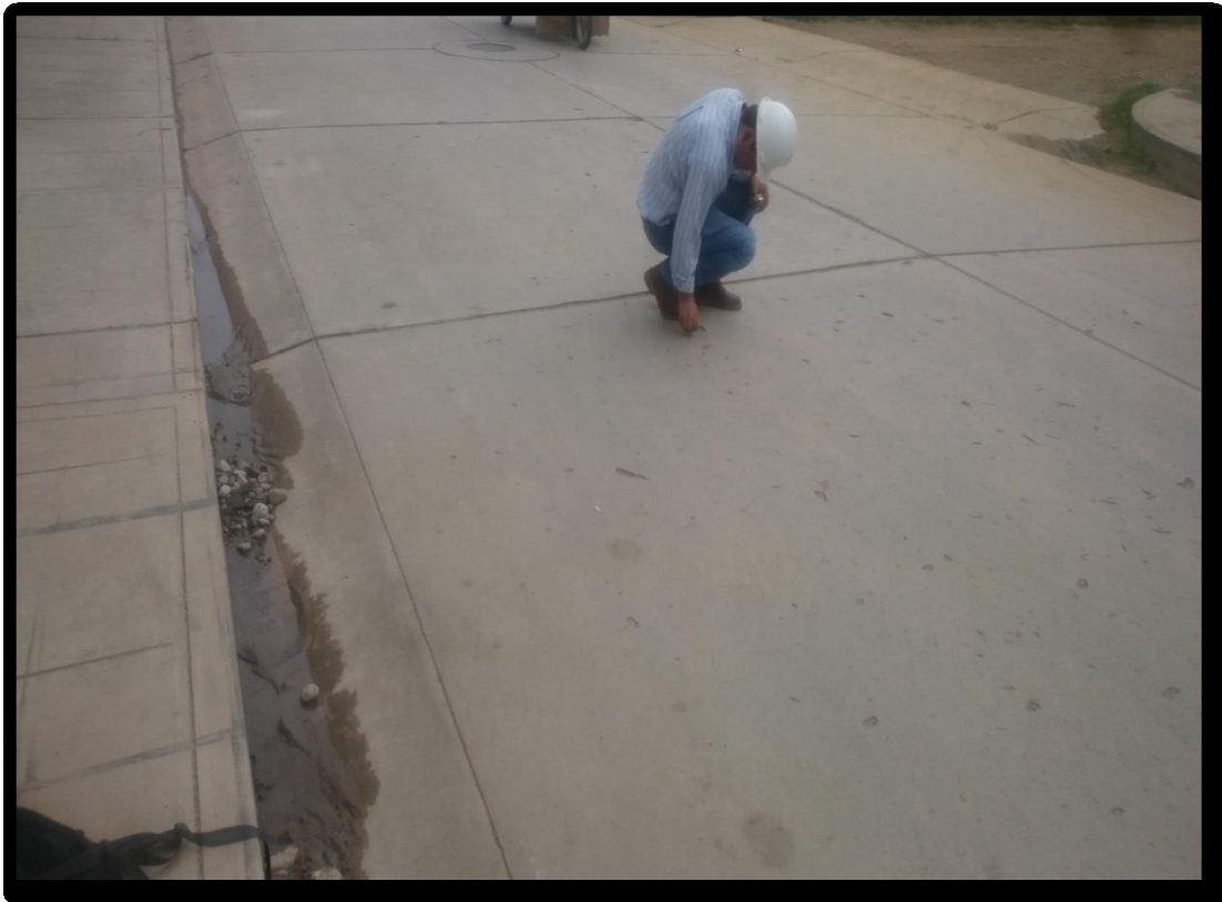
Figura 242. Fotografía con presencia, popoust, (32), identificado en la unidad de muestra 07, del Jirón San Martín, cuadra 08.
