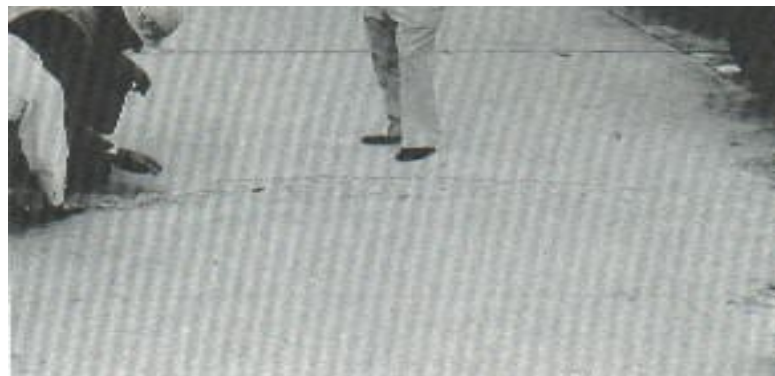
Figura 15. Grieta de durabilidad de severidad media.
