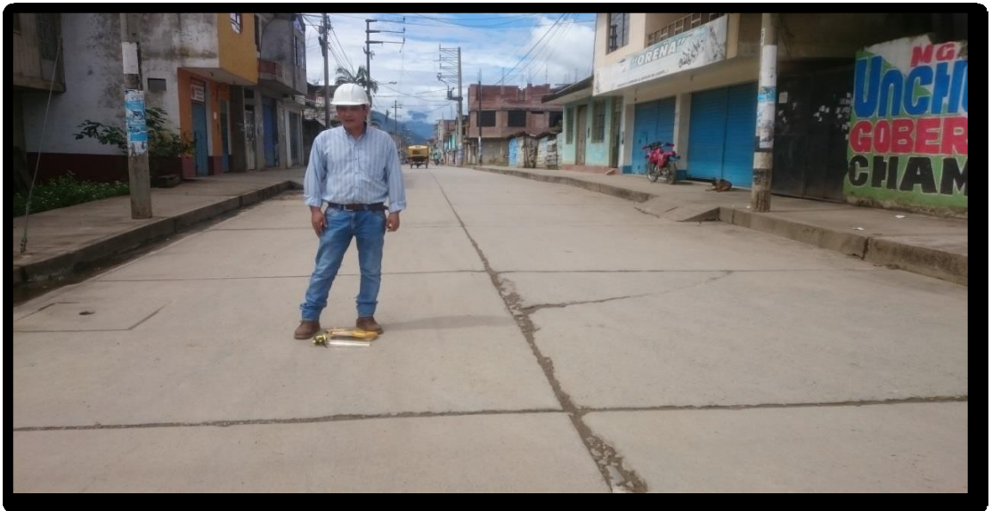
Figura 211. Fotografía con vista panorámica en la cuadra 10, del Jirón San Martín distrito y provincia de satipo.
