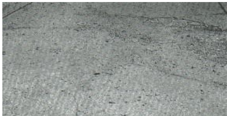
Figura 15. Grieta de durabilidad de severidad media.
