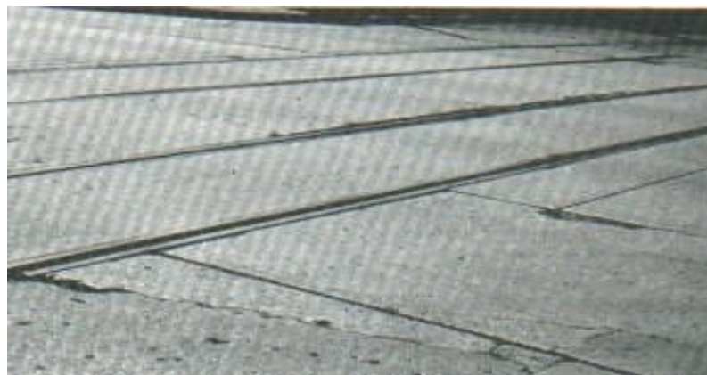
Figura 42. Cruce de vía férrea de baja severidad.
