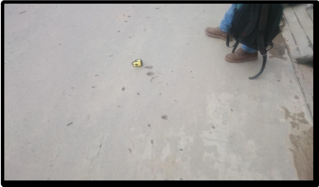
Figura 222. Fotografía con presencia de popoust (32), identificado en la unidad de muestra 02 del Jirón San Martín, cuadra 06.
