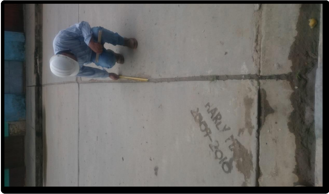
Figura 220. Fotografía con presencia, descascamiento de junta, de nivel de severidad bajo (39L), identificado en la unidad de muestra 02, del Jirón San Martín, cuadra 06.
