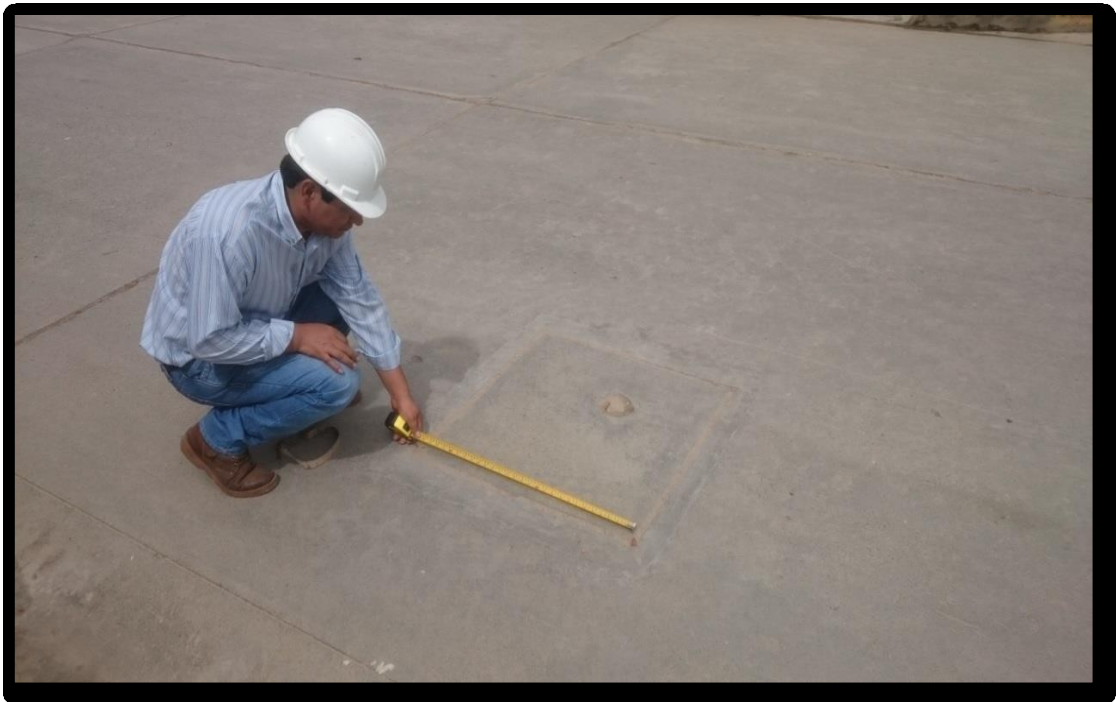
Figura 251. Fotografía con presencia, parche grande mayor a 0.45m 2 de nivel de severidad baja (29L), identificado en la unidad de muestra 09, del Jirón San Martín, cuadra 09.
