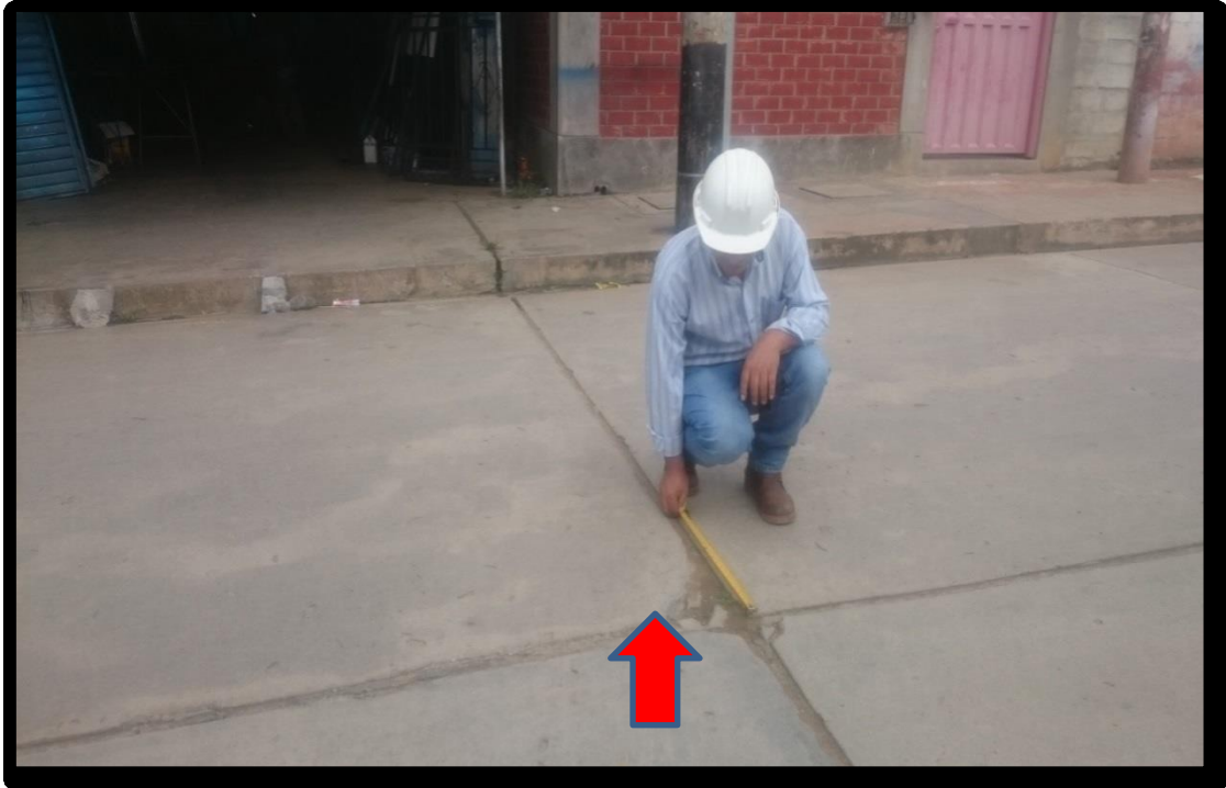
Figura 240. Fotografía con presencia, descascaramiento de esquina de nivel de severidad baja (38L), identificado en la unidad de muestra 07, del Jirón San Martín, cuadra 08.
