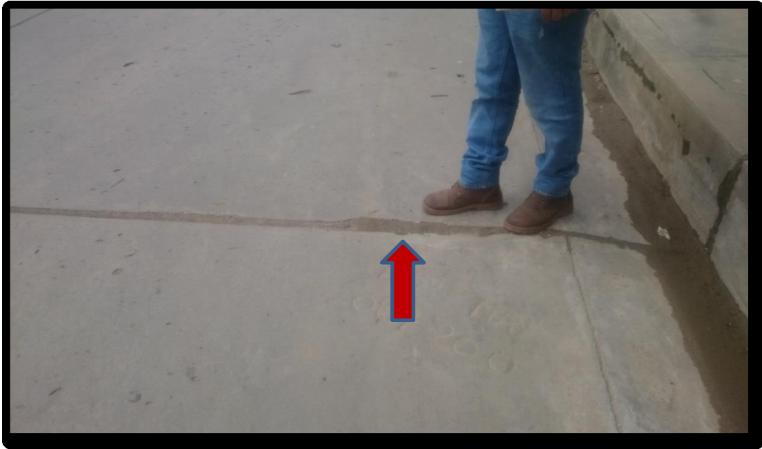
Figura 214. Fotografía con presencia, descascaramiento de junta con nivel de severidad baja (39L), identificado en la unidad de muestra 01, del Jirón San Martín, cuadra 06.
