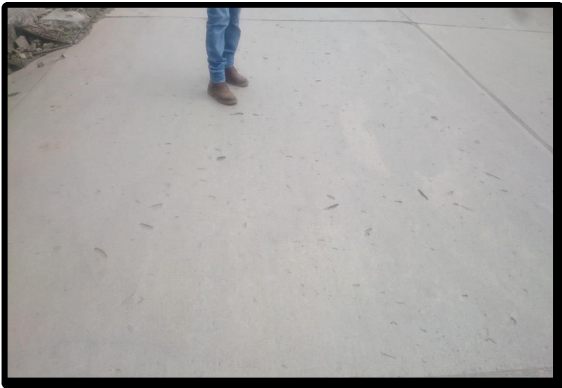
Figura 225. Fotografía con presencia, popoust (32), identificado en la unidad de muestra 03, del Jirón San Martín, cuadra 07.
