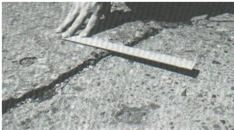
Figura 18. Escala de severidad media.
