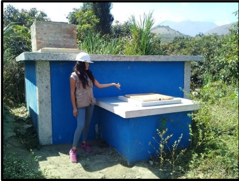
Imagen Nª 05: Reservorio almacenamiento del sistema de abastecimiento, del caserío de Larea Baja, Distrito de Moro, Provincia de Santa, departamento Áncash.
