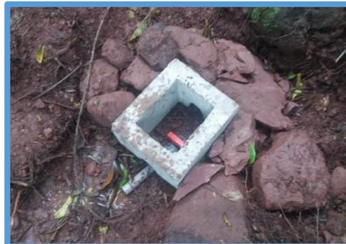
**Figura 34:** Válvula de aire
