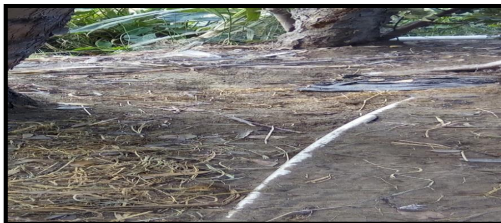
Figura 15. Línea de aducción
