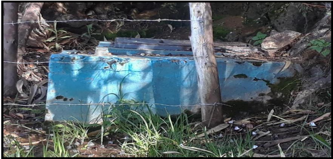
Figura 22. Se muestra el estado en que se encuentra la cámara de captación del Caserío El Milagro, distrito de Independencia, provincia de Huaraz, departamento de Áncash y su incidencia en la condición sanitaria de la población – 2019.
