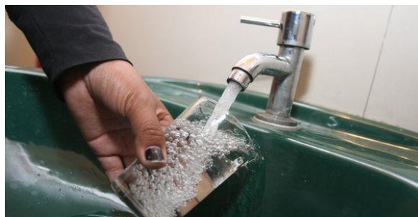
Imagen 17 Continuidad del servicio de agua potable
