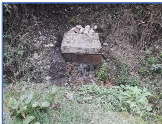
Figura 18. Vista externa de la captación Agua Blanca del sector Katanya
