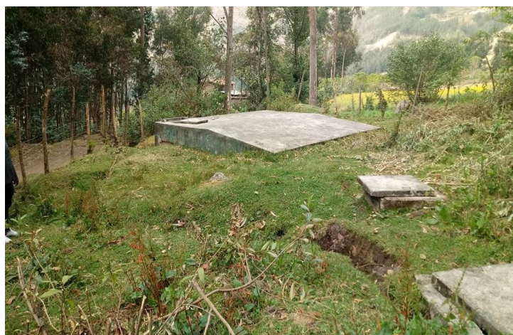
Figura 24. Reservorio de almacenamiento existente
