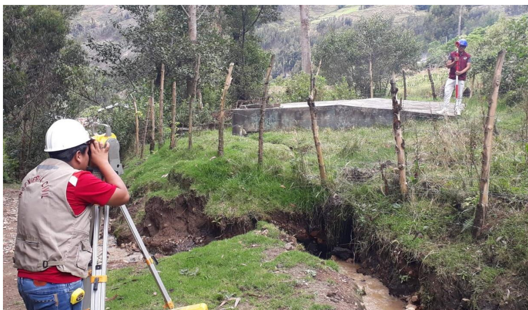
Imagen 16: Vista fotográfica del levantamiento topográfico en el reservorio actual del sector de Katanya.
