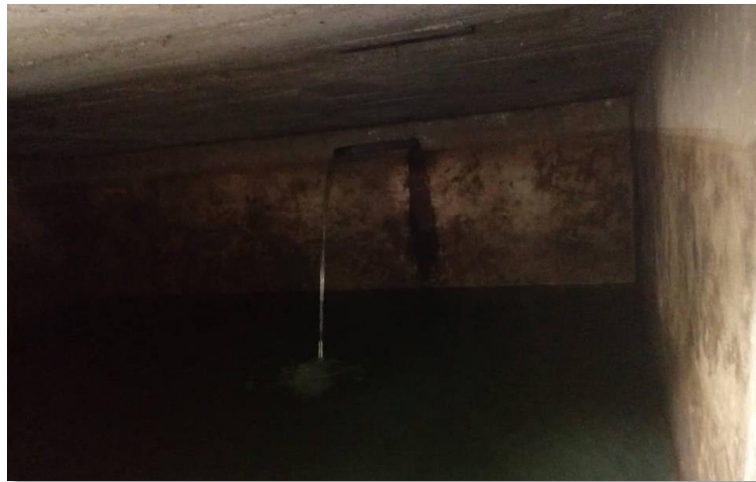
Figura 26. Vista interna del reservorio de almacenamiento
