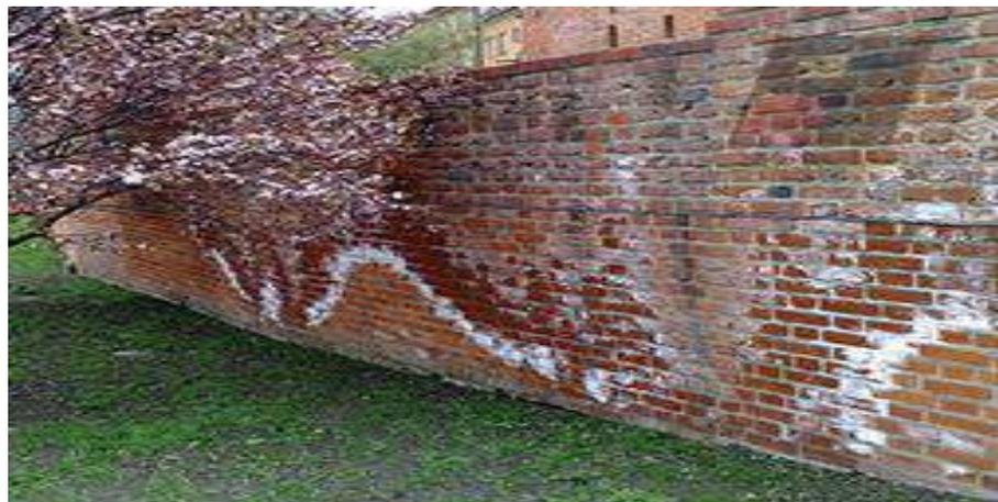
**Figura 15:** Muro afectado por la eflorescencia.
