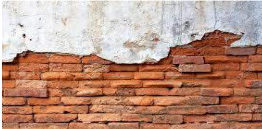
**Figura 18:** Erosión en muros de ladrillo.
