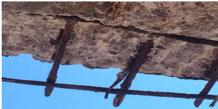
**Figura 16:** Oxidación en vigas de concreto armado.
