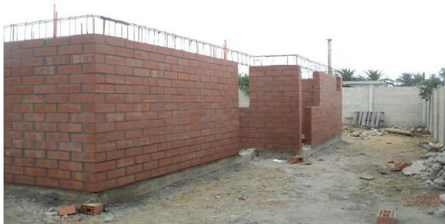
**Figura 03:** Albañilería simple.
