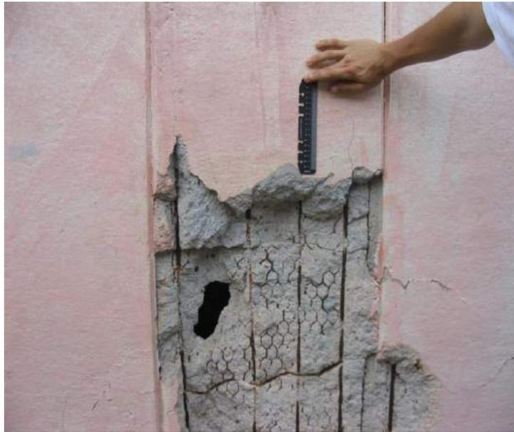
**Figura 14:** Desintegración en el concreto en una columna convencional
