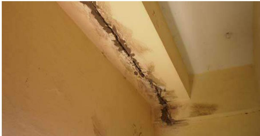
**Figura 10:** Grieta en viga de concreto armado
