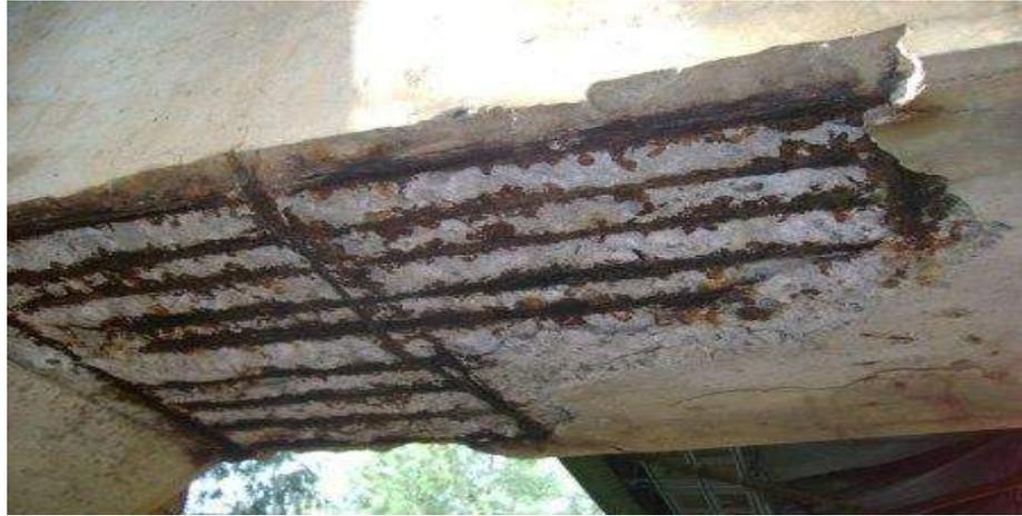
**Figura 12:** Corrosión del acero en viga de concreto armado
