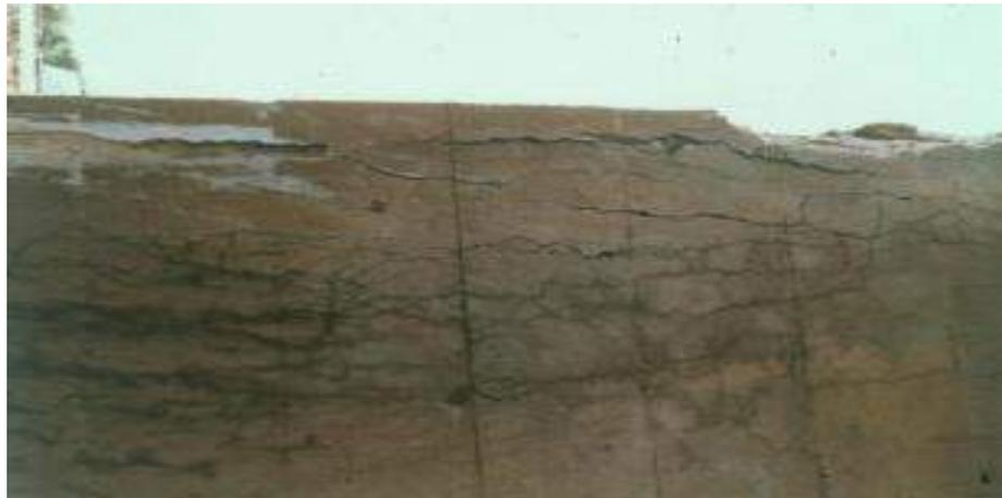
**Figura 17:** Delaminación en muros.
