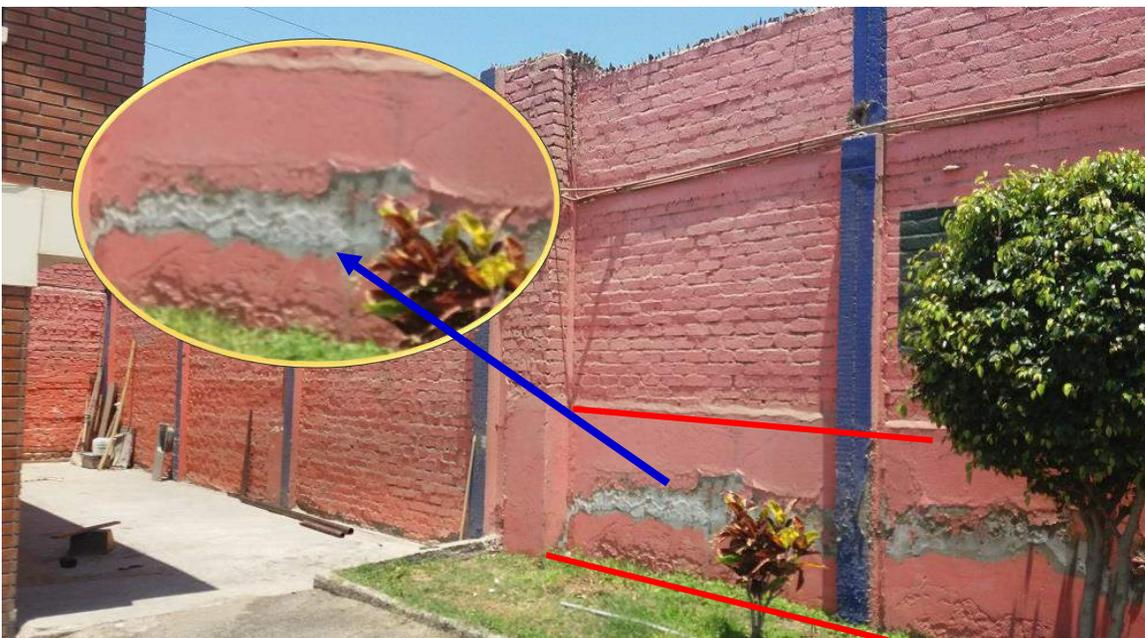
**Figura 26:** Foto donde se aprecia el muro afectado por la patología de delaminación en la unidad de muestra 03.
