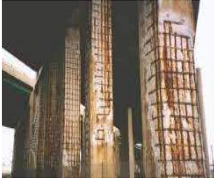
**Figura 13:** Corrosión del acero en columnas de concreto armado.
