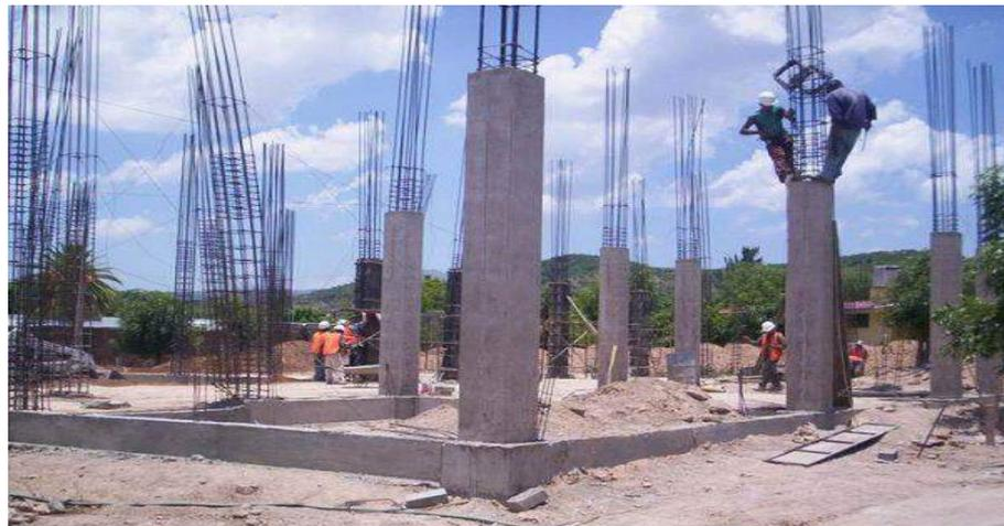
**Figura 06:** Columna de concreto armado.
