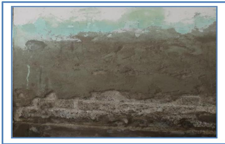
*Imagen 08: desprendimiento en muros.*
