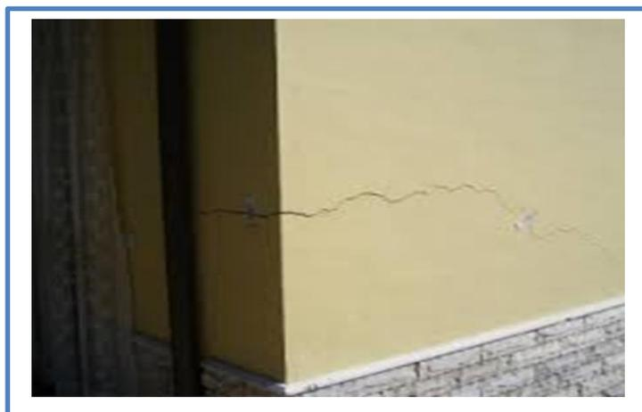
*Imagen 05: Patologías – grietas en muros de albañilería.*
