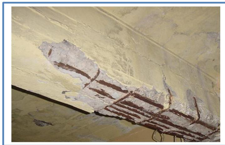
*Imagen 09: corrosión en la viga peraltada.*
