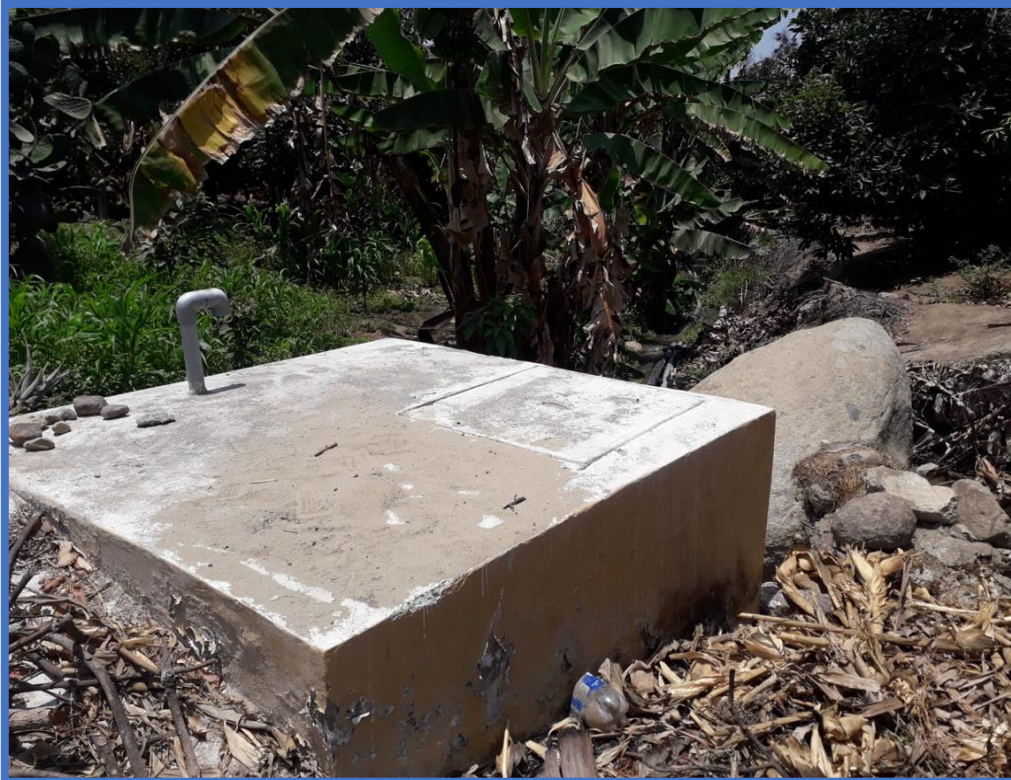
Imagen N° 03. – Se aprecia su reservorio almacenan el agua.
