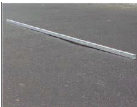
Ondulación de severidad Media
