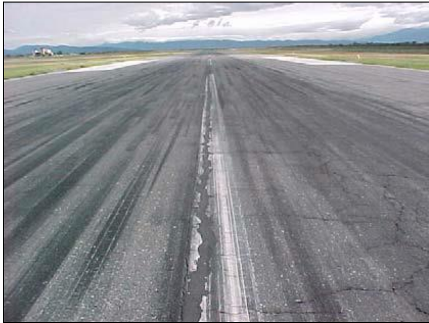
Figura de Bloque de Baja severidad
