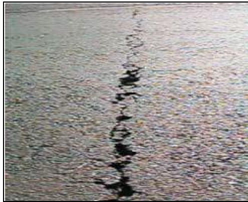
Reflexión de junta de Alta severidad
