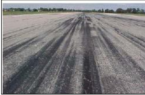
Erosión por Ráfaga de Jet
