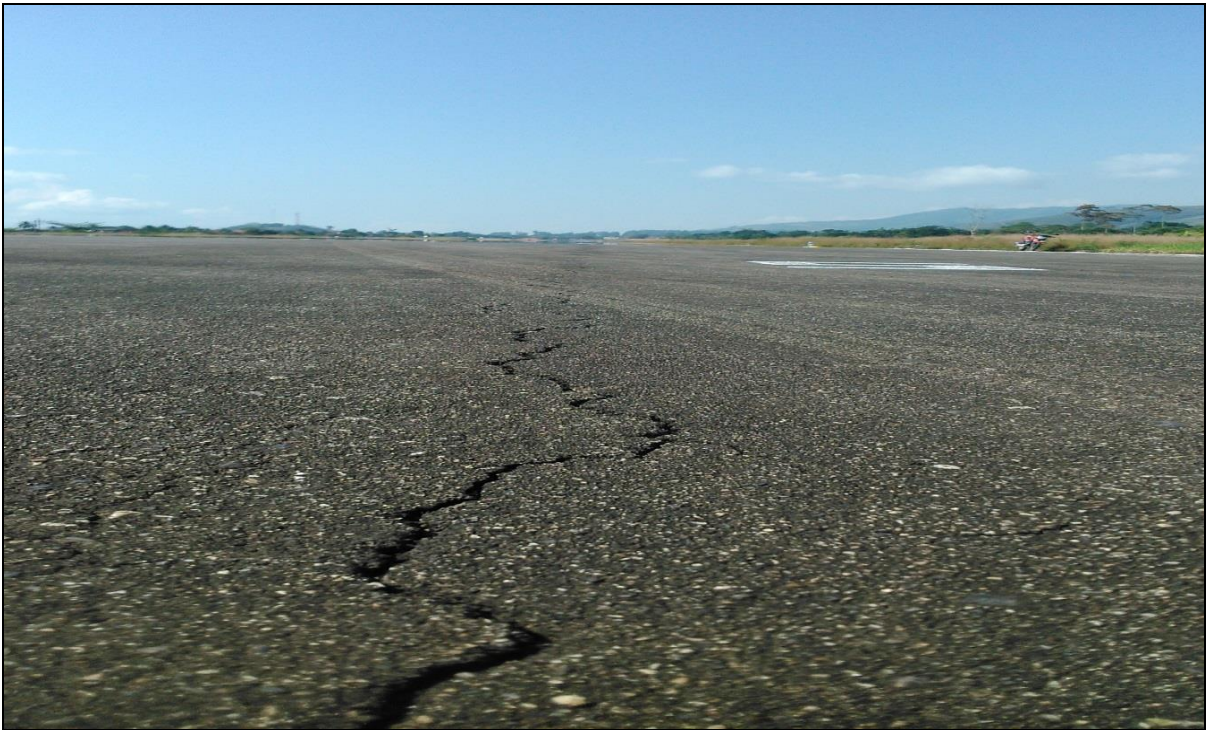
Fisura Longitudinal
