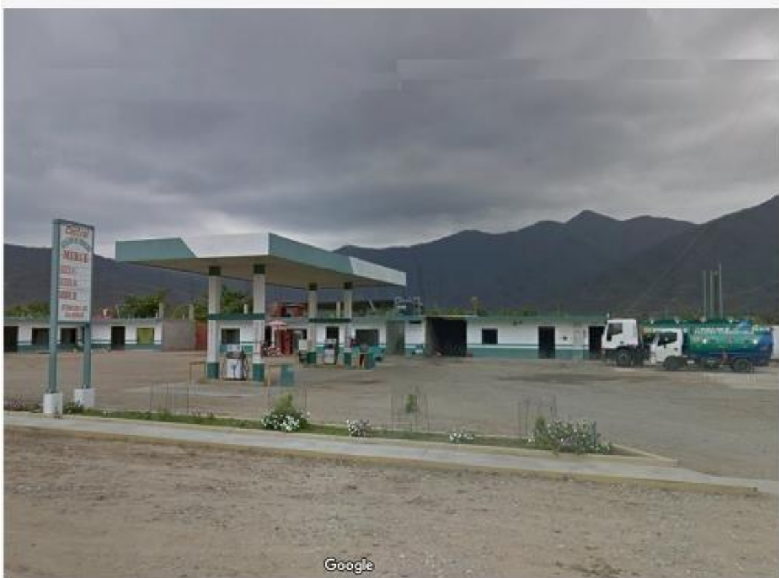
Foto: Oficina central “Estaciones de Servicios Merce S.A.C”
