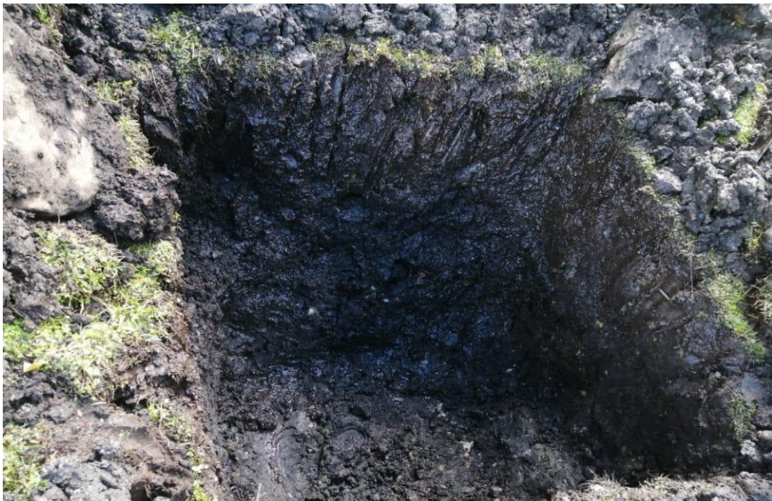
FIGURA 40. Excavación de calicata para realizar el EMS en captación. Fuente: elaboración propia.
