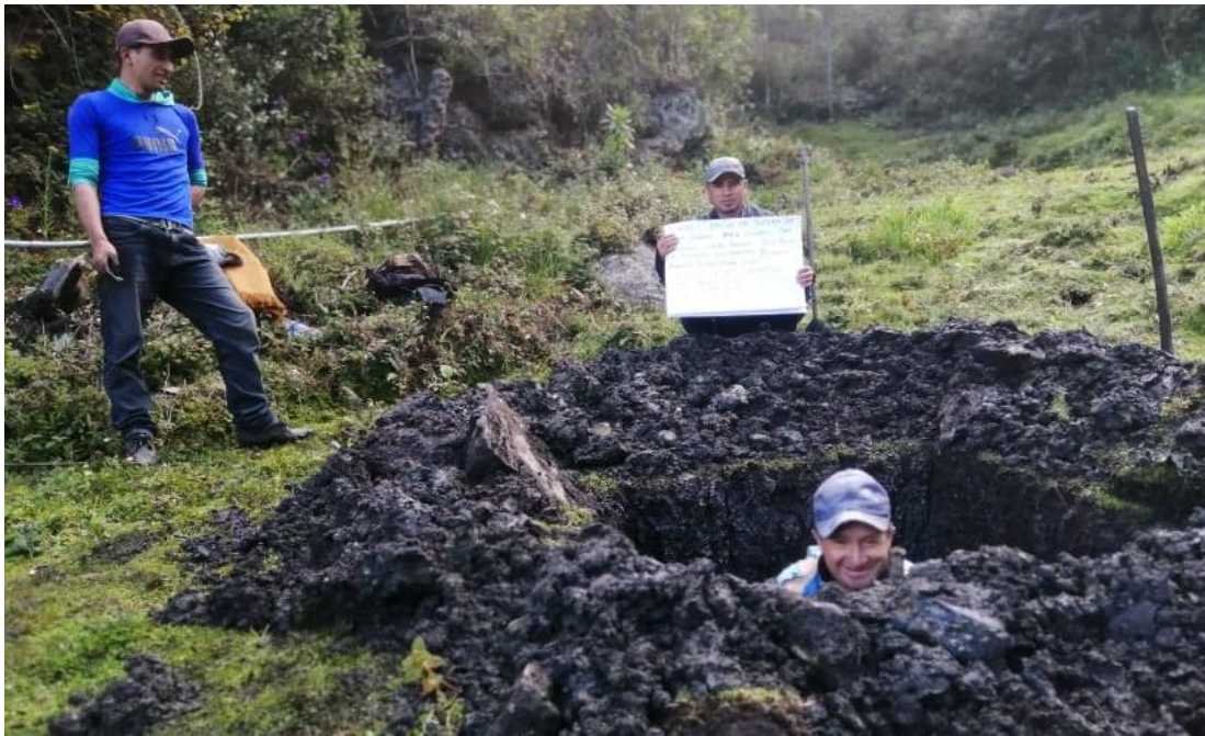
FIGURA 39. Excavación de calicata en captación. Fuente: elaboración propia.
