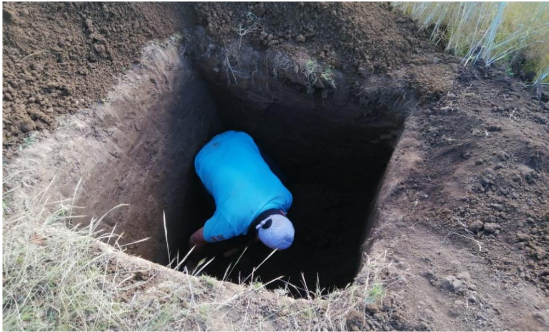
FIGURA 41. Excavación de calicata para reservorio. Fuente: elaboración propia.
