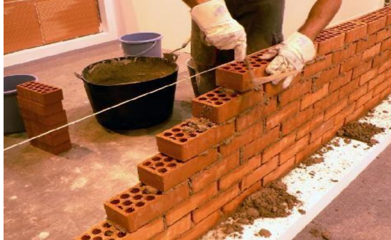
Figura 01: Albañilería simple
