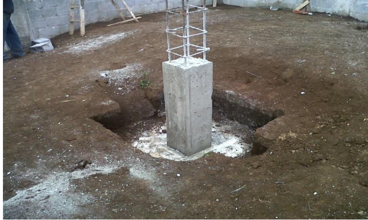
Figura 06. Imagen de columna
