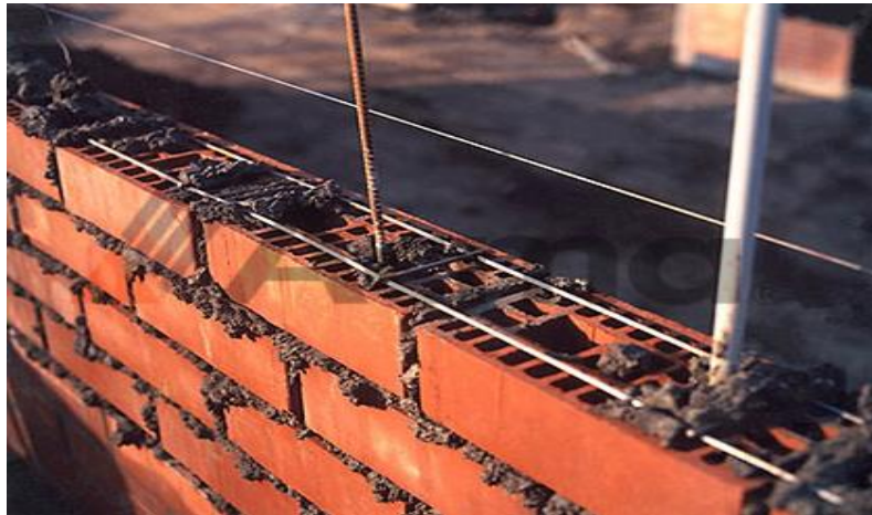
Figura 02: Albañilería armada.
