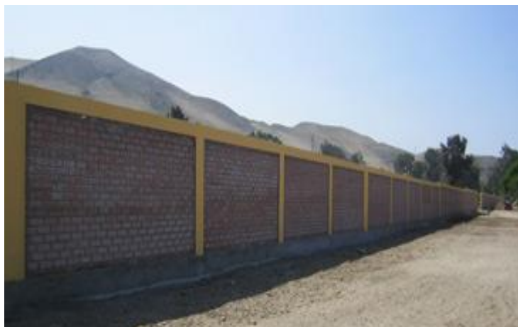
Figura 04. Imagen de cerco perimétrico
