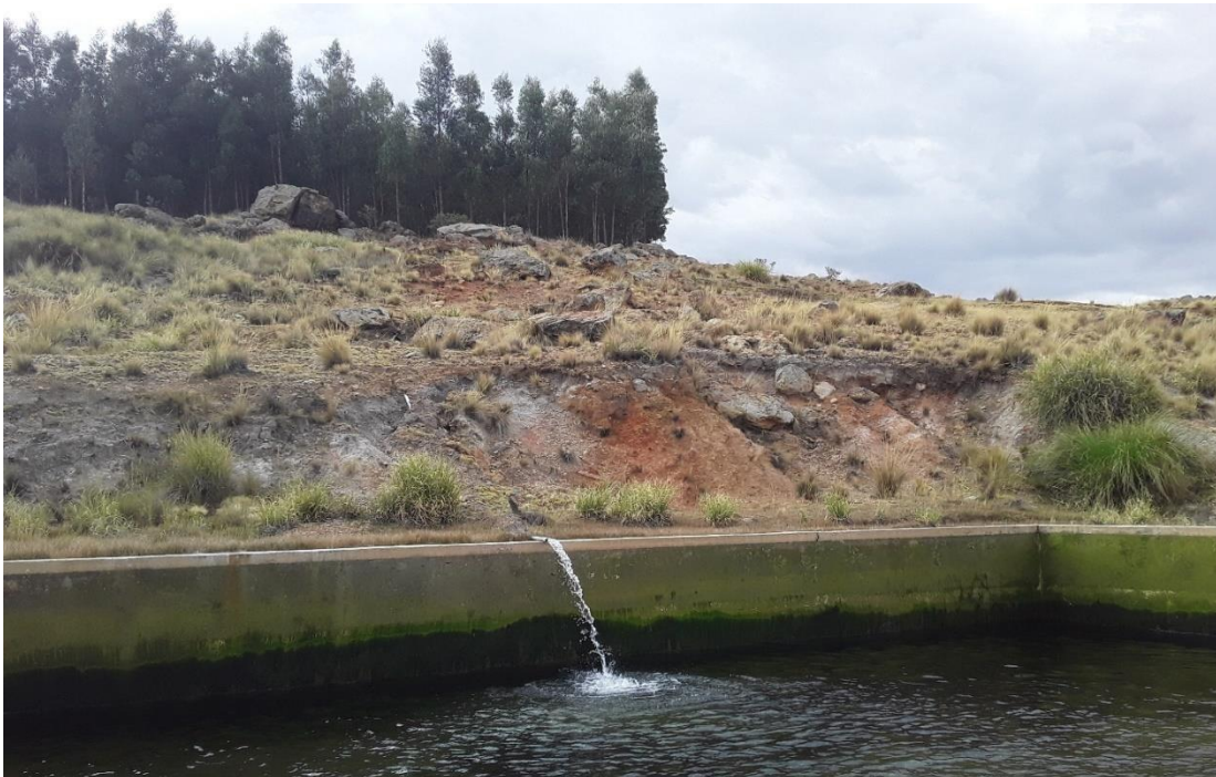
Fotografía N. 02: Vista de muro sur del reservorio de riego.
