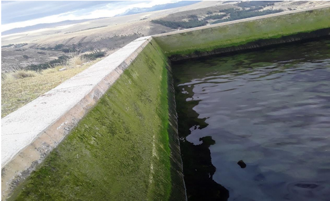
Fotografía N. 03: Vista de muro oeste del reservorio de riego.
