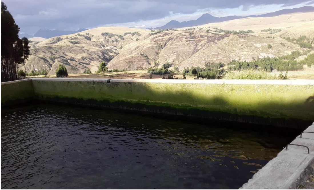
Fotografía N. 01: Vista de muro norte del reservorio de riego.
