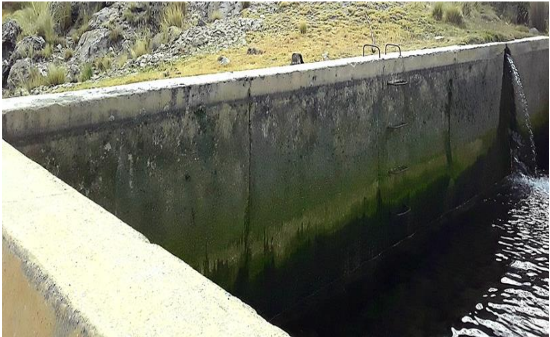
Fotografía N. 04: Vista de muro este del reservorio de riego.
