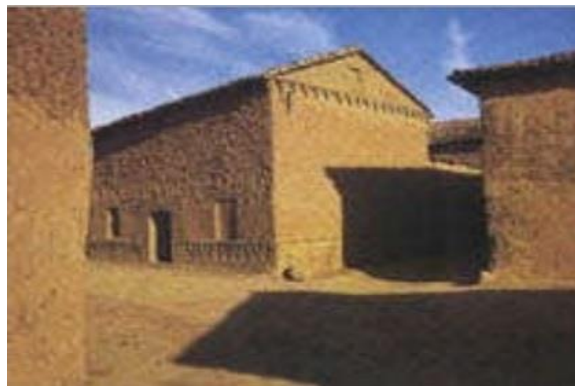
Imagen 8: Vivienda construida mediante albañilería simple
