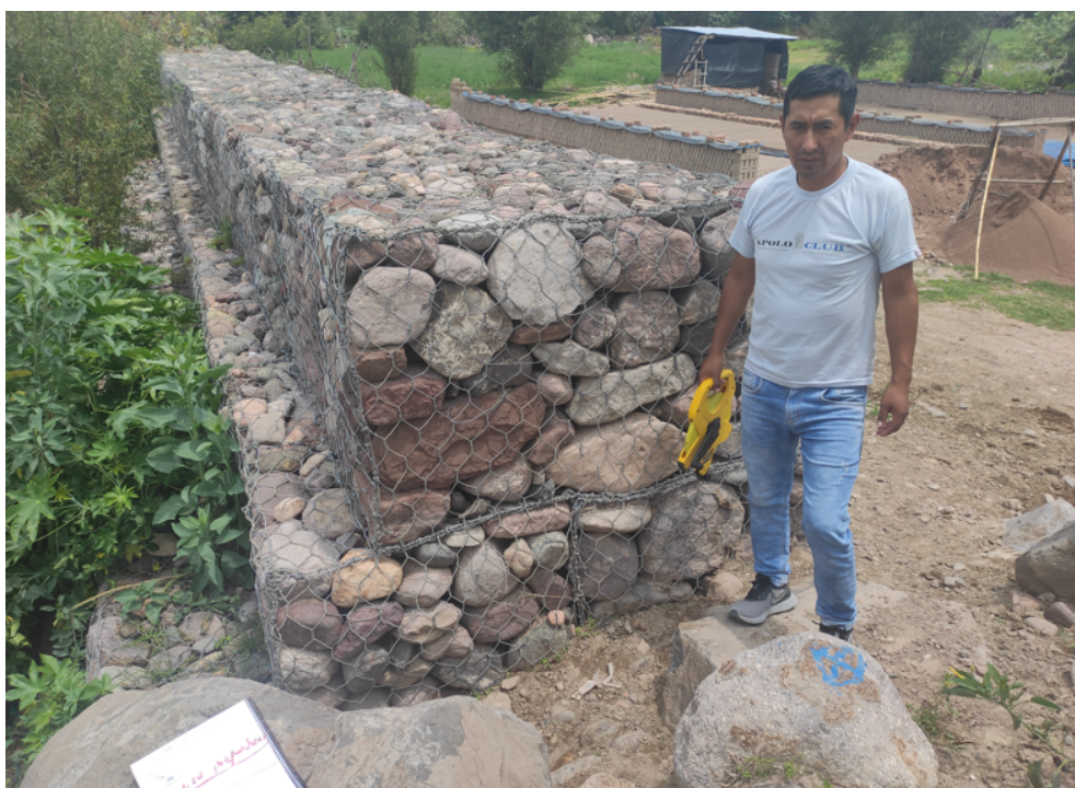
Figura 5.4: Vista de gavión.
