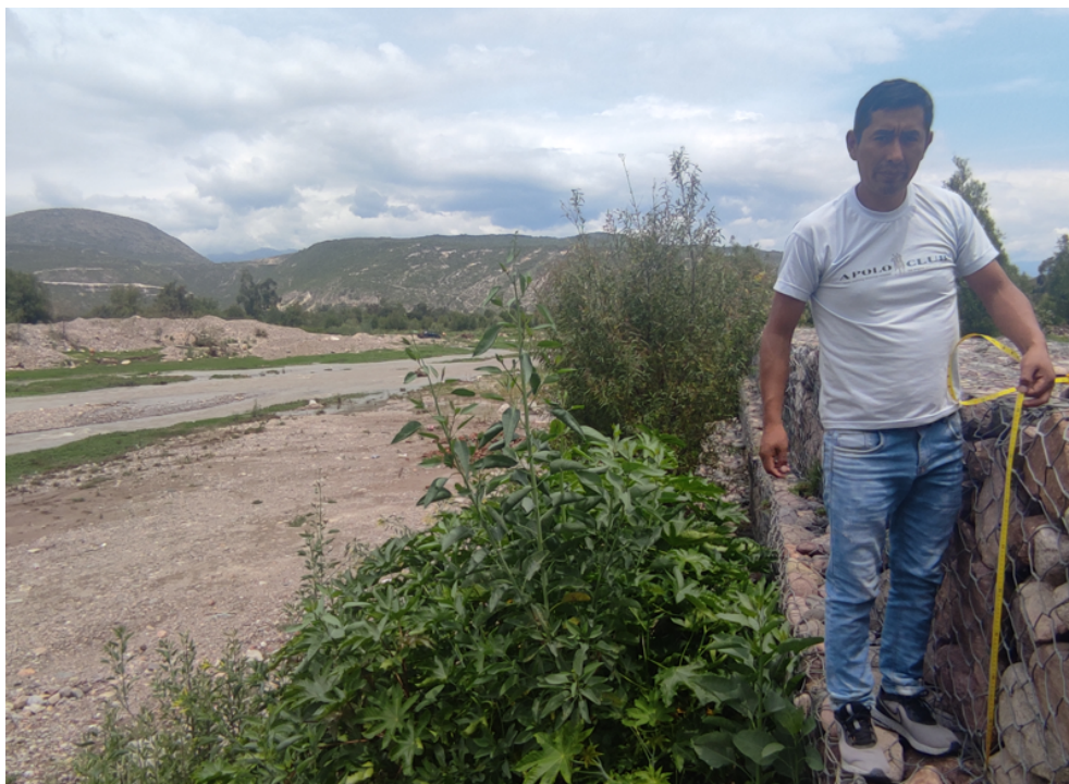
Figura 5.3: Medición de la altura de gavión.
