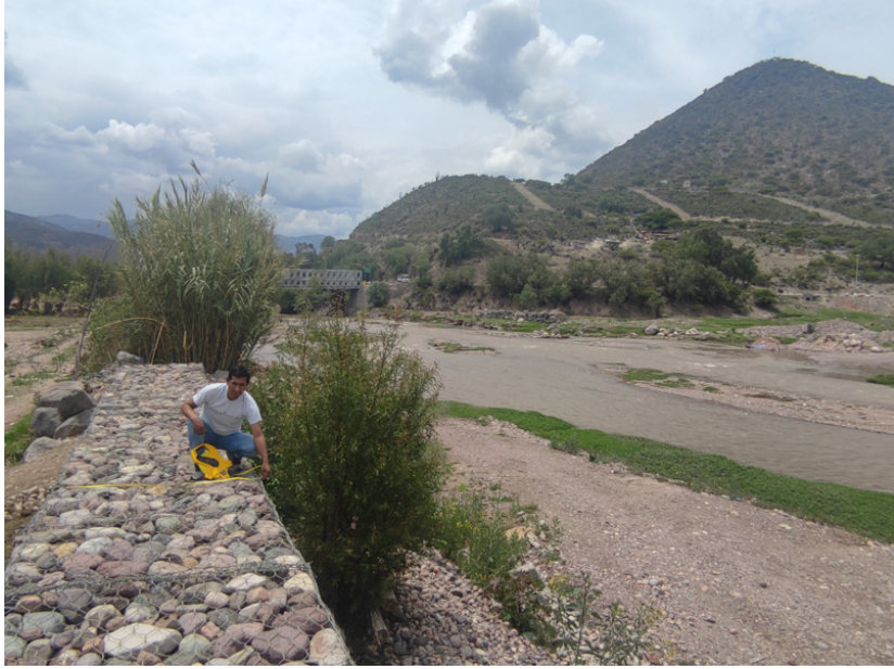
Figura 5.5: Medición del ancho de gavión. Fuente: Elaboración propia.
