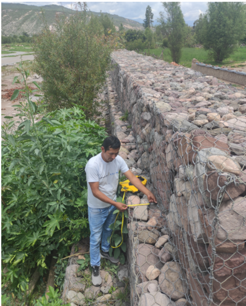
Figura 5.7: Medición de la altura de gavión.
