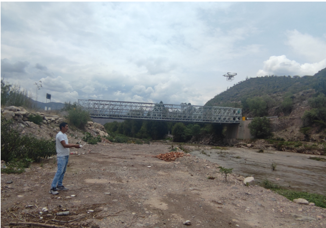
Figura 5.9: Toma de datos con el drone.
