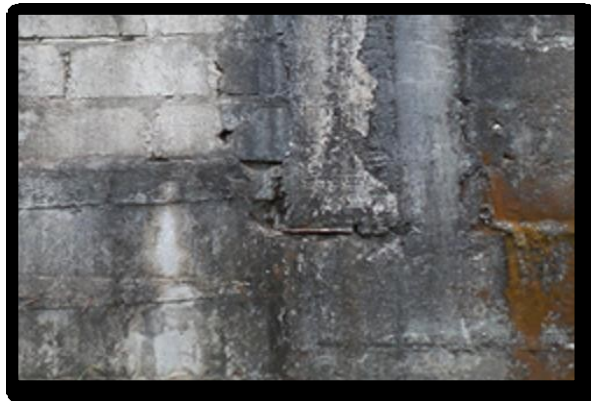
Figura 8. Oxidación del acero.
