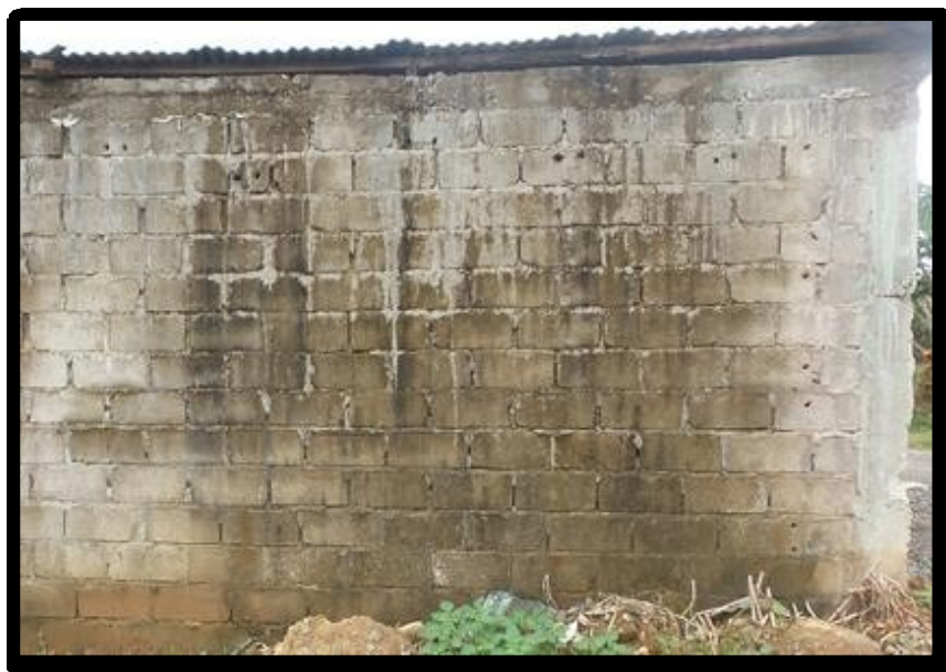
Figura 10. Humedad en el concreto.
