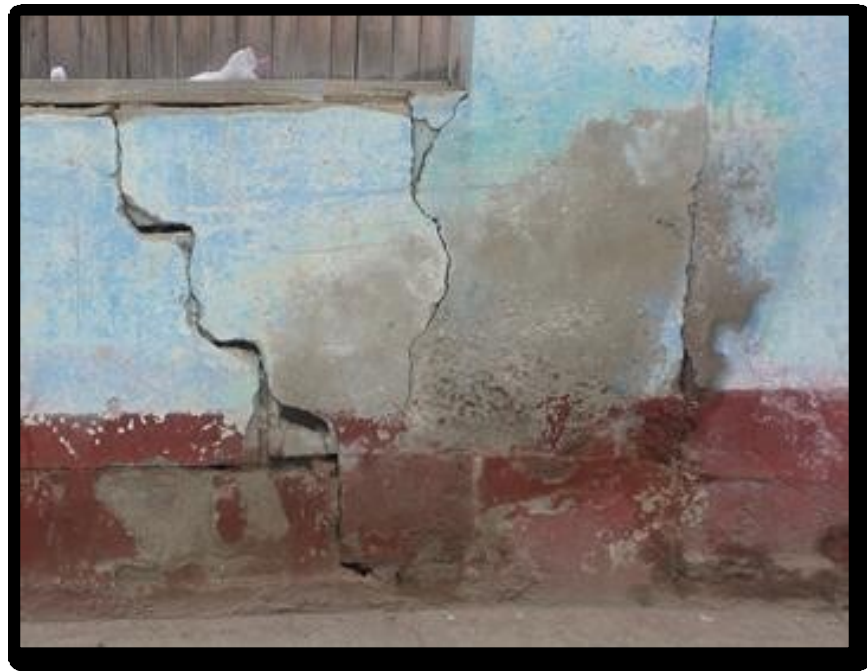
Figura 12. Agrietamiento Vertical
