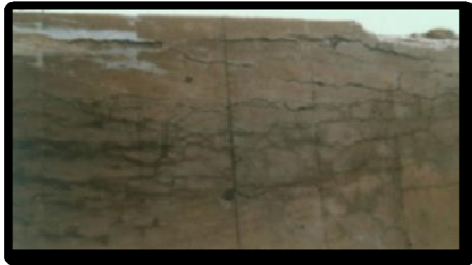
Figura 7. Delaminación del agregado.
