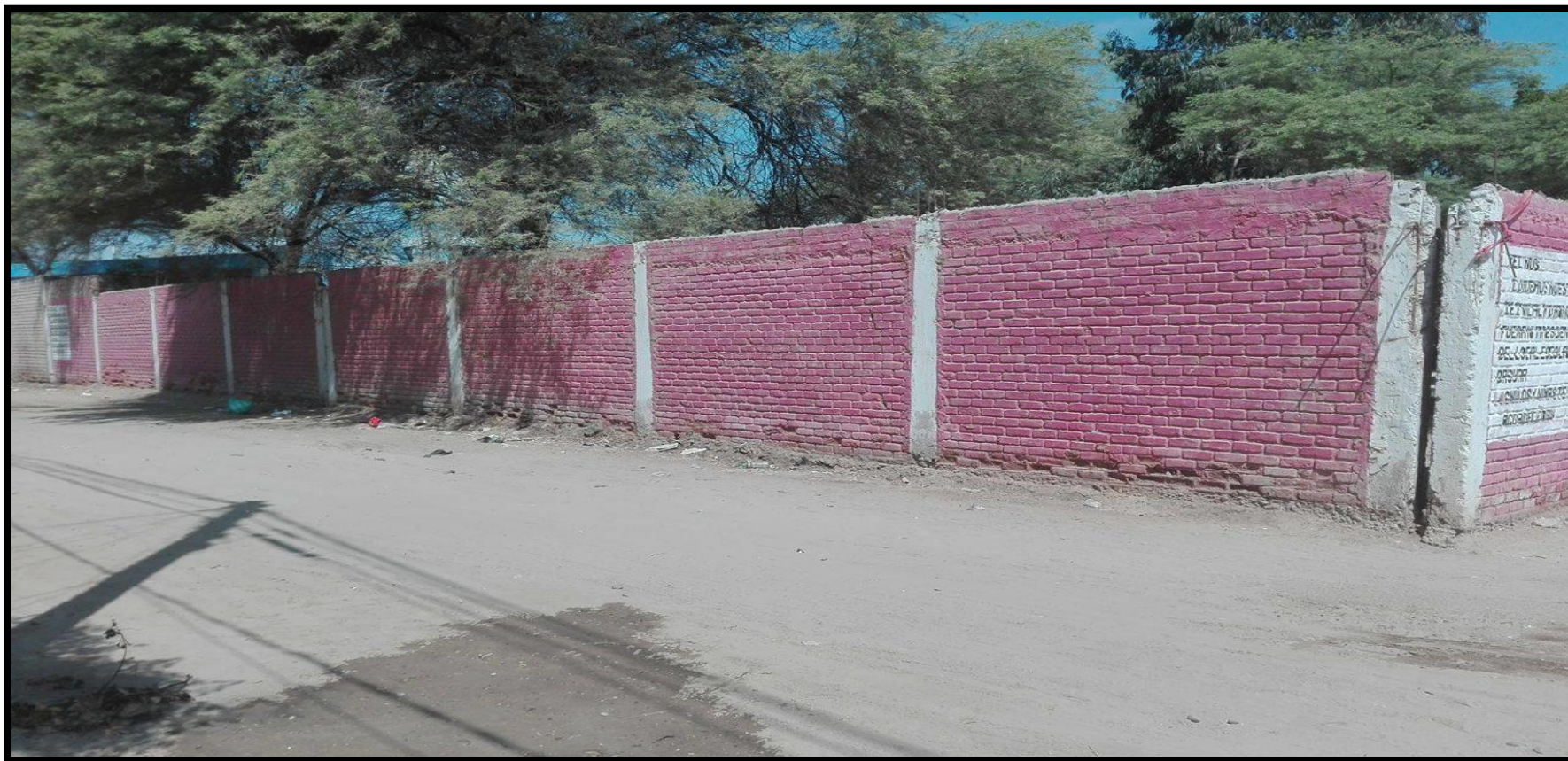
Imagen 10: Foto panorámica de la calle Ca. Hector Patorro del cerco perimétrico de la Institución Educativa Inicial 071.
