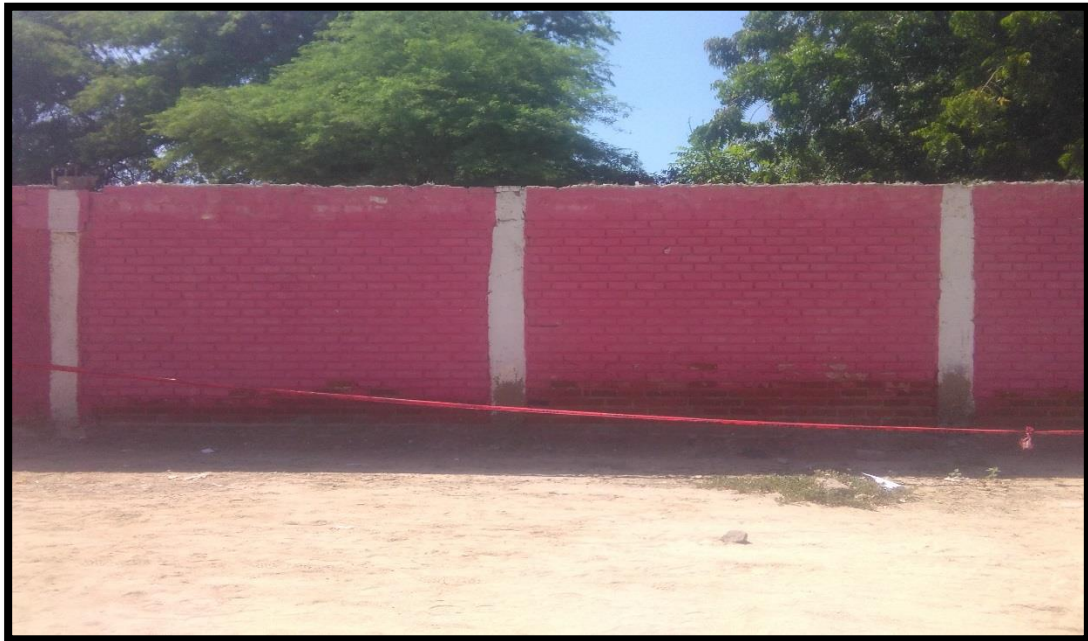
Imagen 17: Identificación de Erosión, UM 05 calle Psj.F.Cossio del Pomar.
