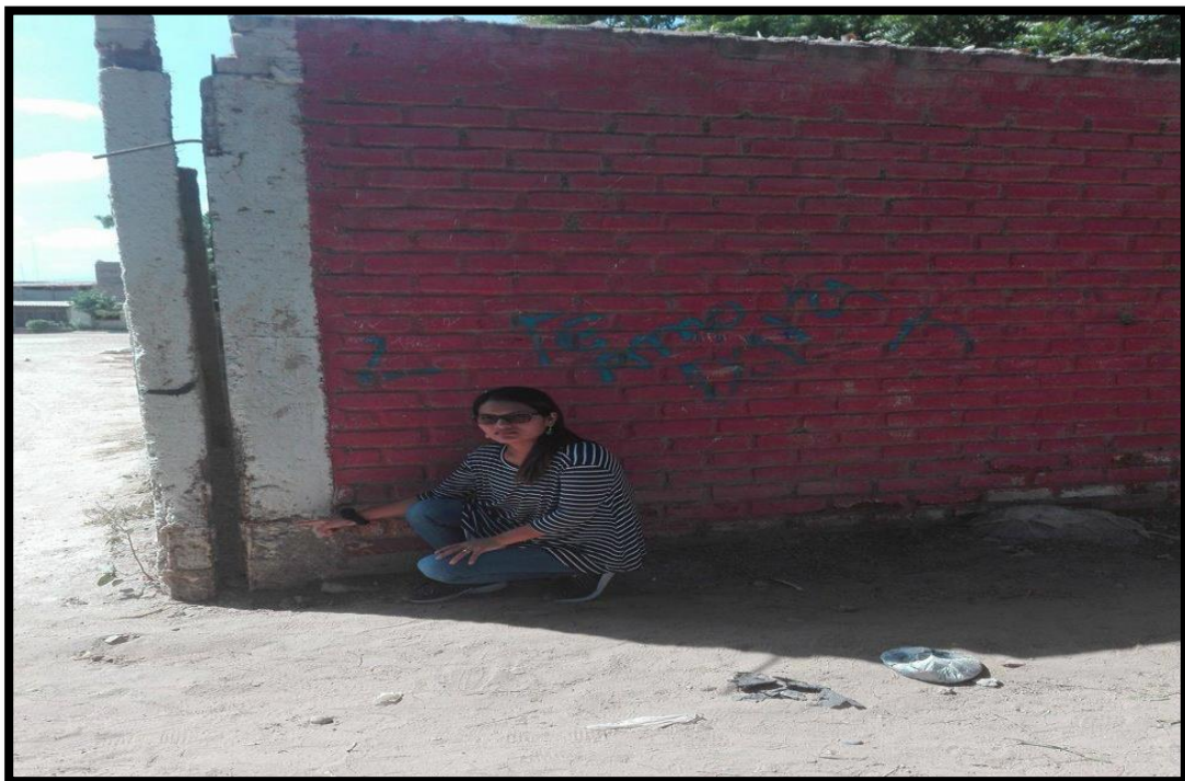
Imagen 22: Identificación de Desprendimiento, Corrosión y Eflorescencia, UM 12 calle Ca. Robles Razuri.
