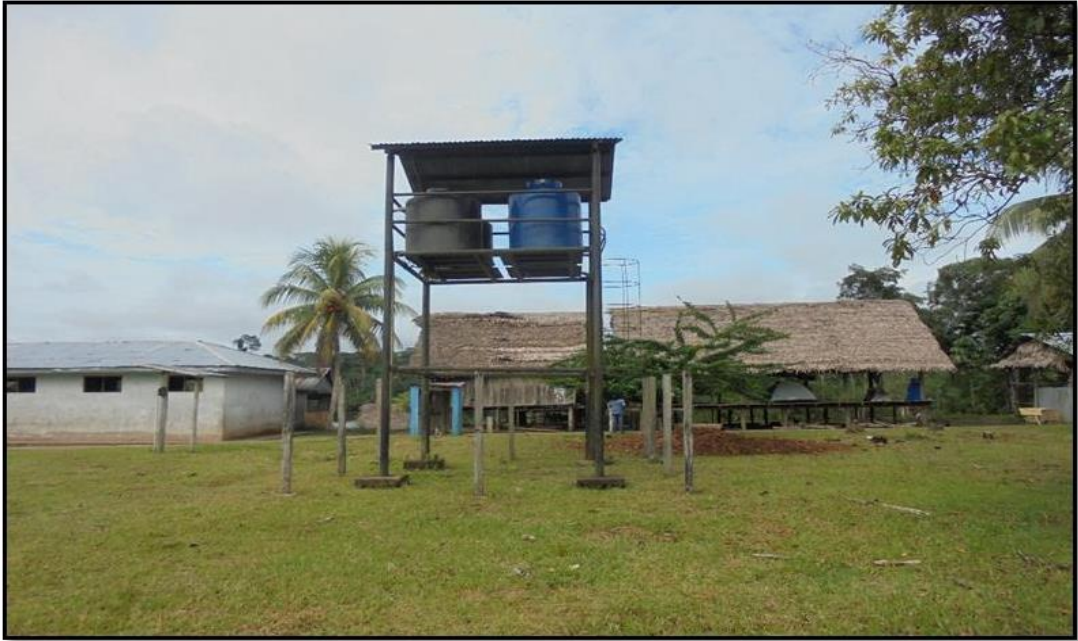
Se observa el Tanque elevado que consta de 4 Und de Rotoplas de 1,100lt, actualmente operativo
