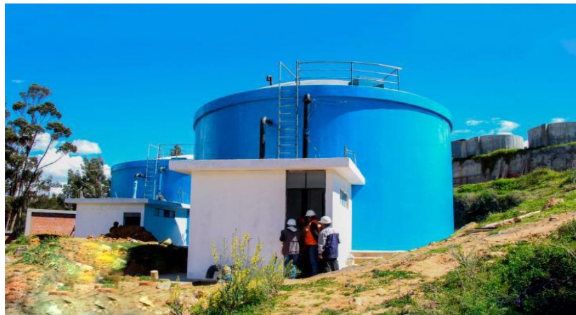
Figura 3: Reservorio de almacenamiento de agua.
