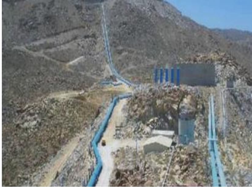
Figura 4: Línea de aducción de agua
