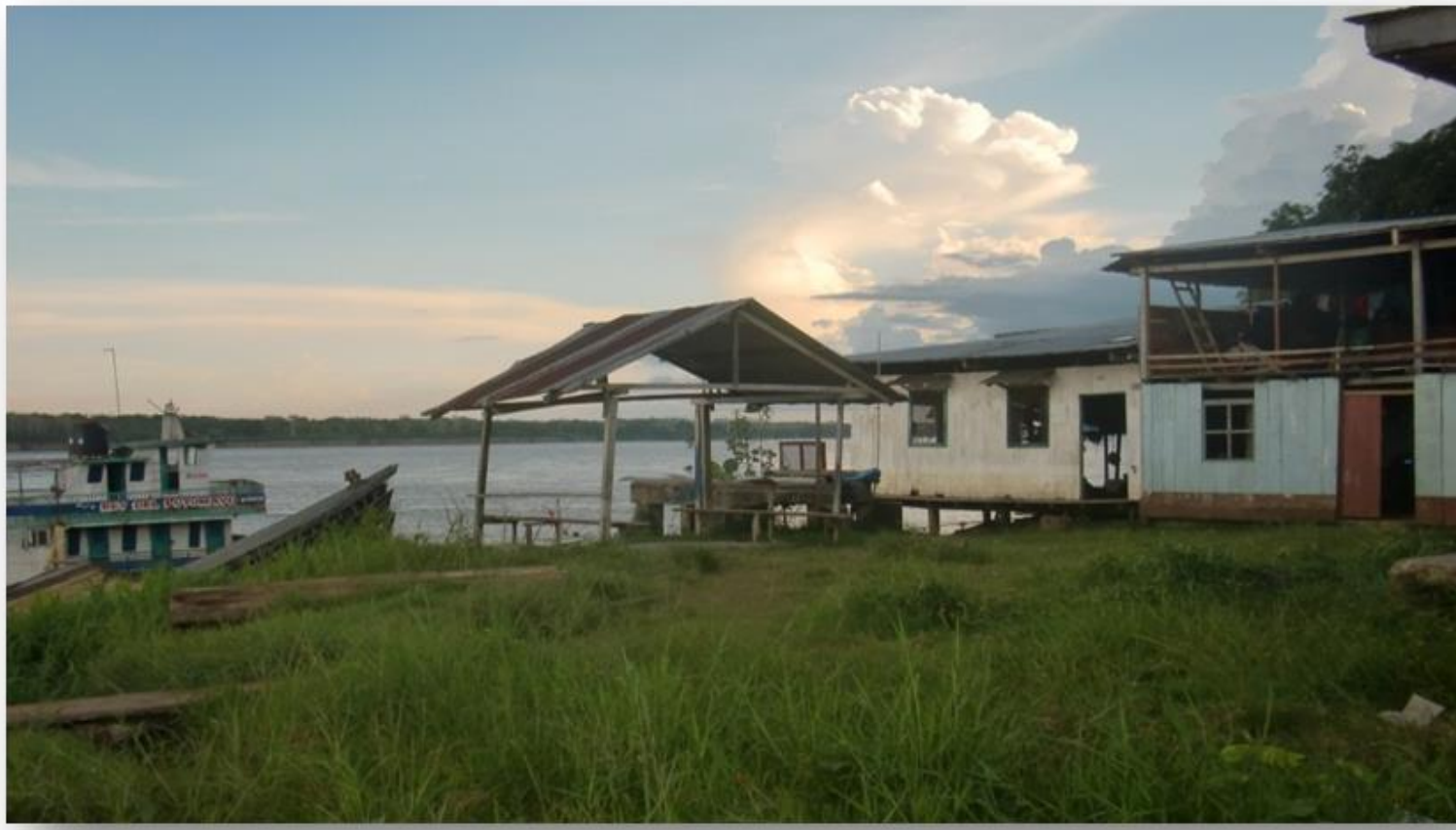
Vista del Rio Marañón, punto actual de captación proyectado
