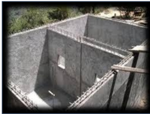
Imagen 8. Tanque de almacenamiento en concreto y mampostería.
