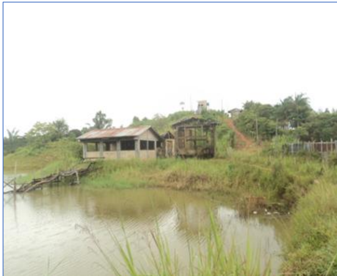
Imagen 1: Captación de la localidad de nauta constituidas por una estación de bombeo equipada con una electrobomba.
