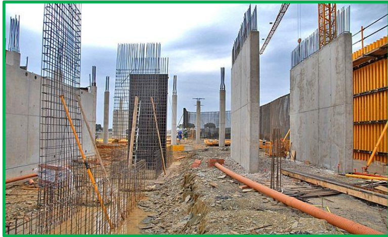
Figura 17. Muro de Corte o Placas
