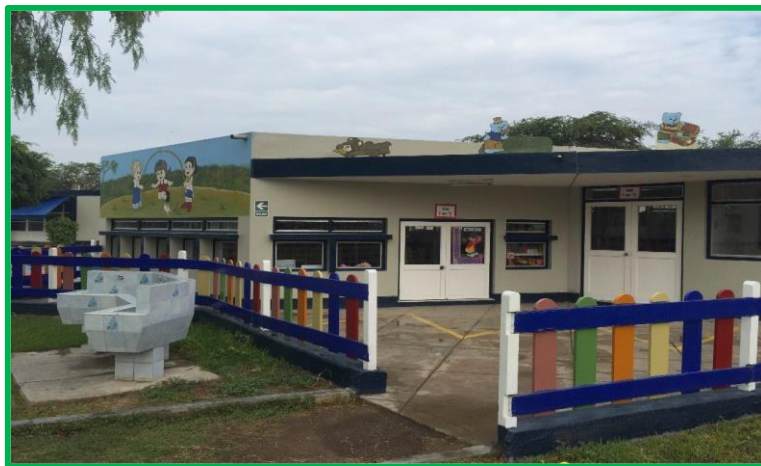
Figura 8. Vista general del Pabellón Inicial
