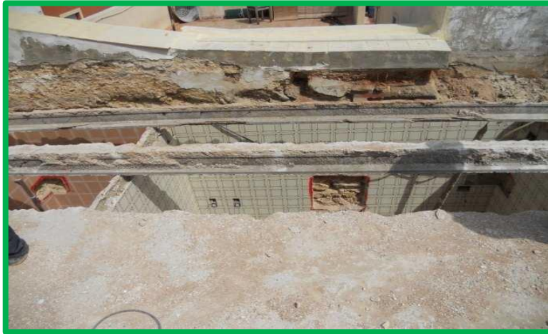
Figura 5. Cubierta plana de hormigón
