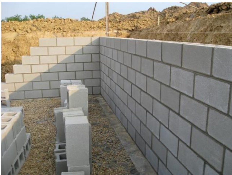
Imagen 07: Detalle de albañilería simple.
