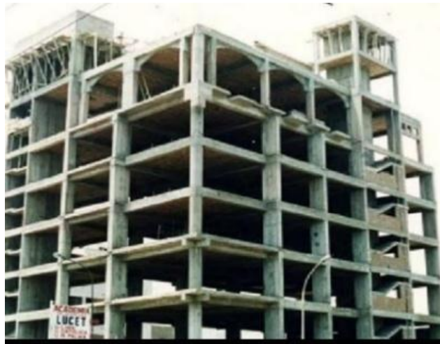
Imagen 04: Sistema Estructural aporticado, columnas y vigas.
