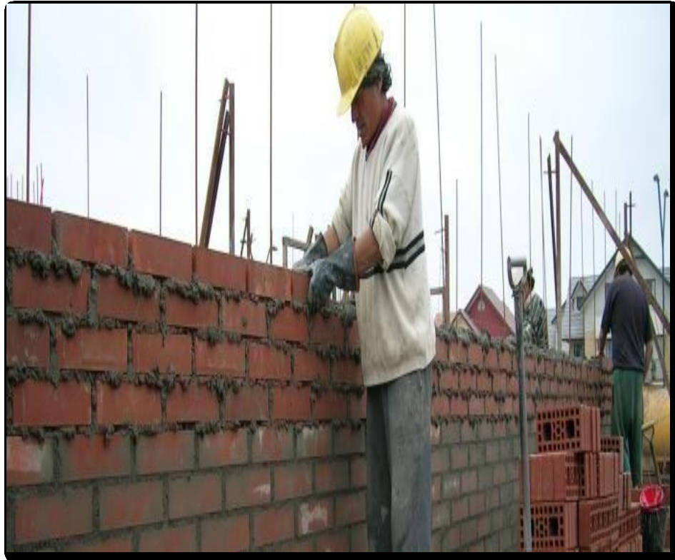
Imagen 9: Detalle de albañilería armada.
