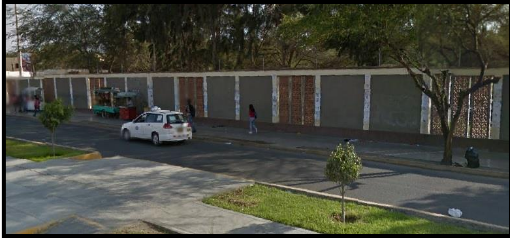
Fotografía n° 07. Vista panorámica del Tramo N° 21 parte posterior de la Universidad Nacional del santa
