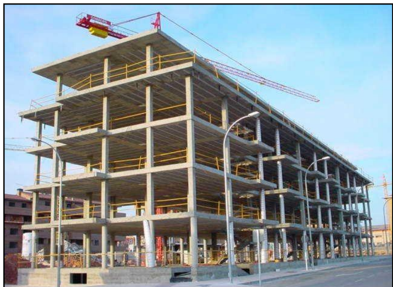
Gráfico 1: Estructura aporticada de una edificación.
