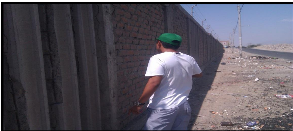
Fotografía n° 07. Vista panorámica del Tramo N° 07 parte posterior de la Universidad Nacional del santa
