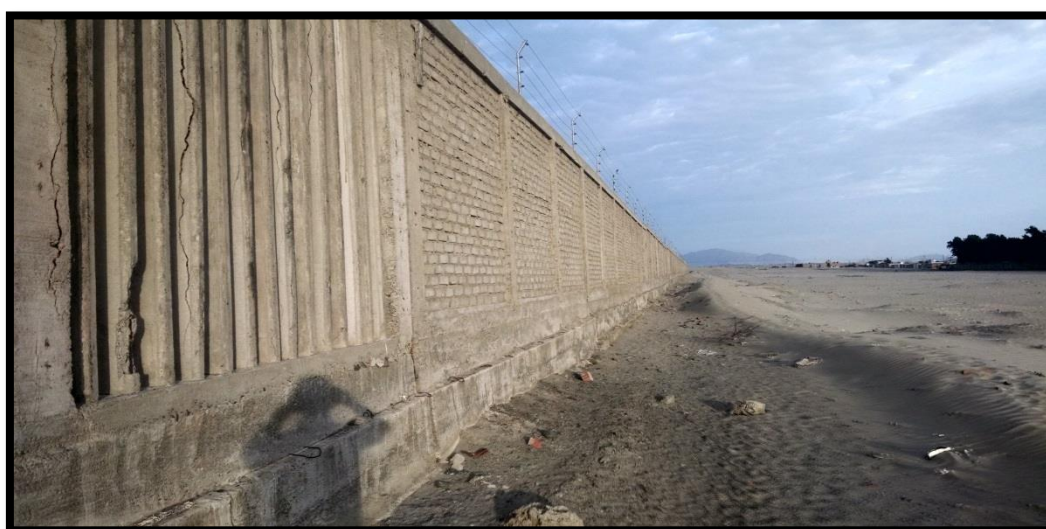
Fotografía n° 07. Vista panorámica del Tramo N° 26 parte posterior de la Universidad Nacional del santa
