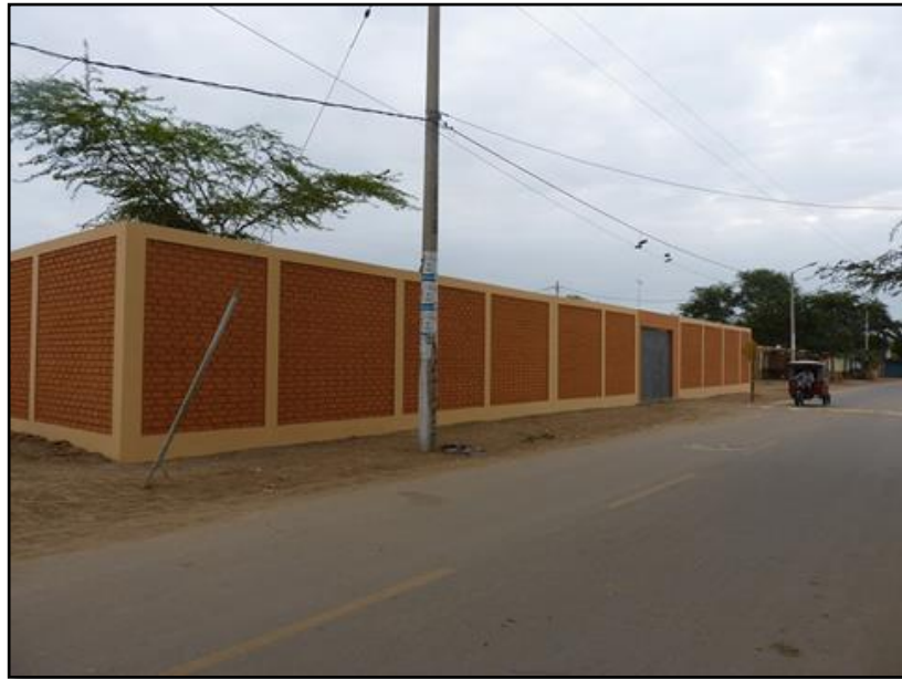
Gráfico 10: Vista panorámica de un cerco perimétrico de albañilería confinada.
