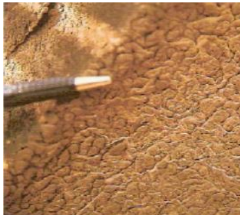
Gráfico 22: Depósito de polvo en un muro.
