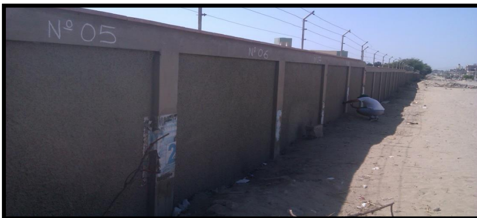
Fotografía n° 07. Vista panorámica del Tramo N° 12 parte posterior de la Universidad Nacional del santa
