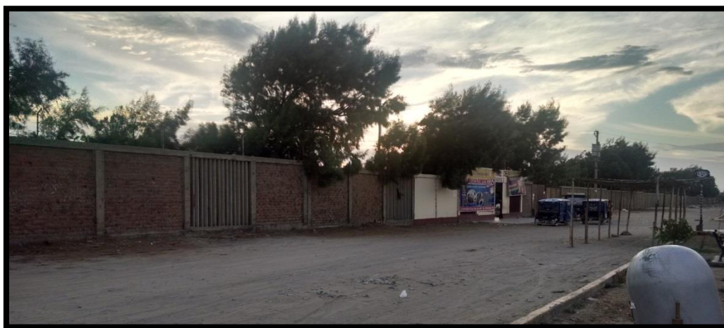
Fotografía n° 07. Vista panorámica del Tramo N° 08 parte posterior de la Universidad Nacional del santa
