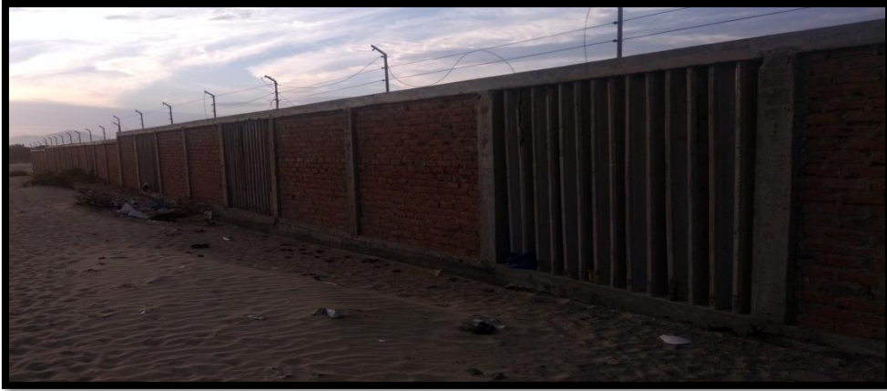
Fotografía n° 07. Vista panorámica del Tramo N° 04 parte posterior de la Universidad Nacional del santa
