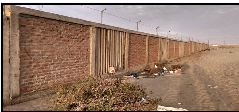
Fotografía n° 06. Vista panorámica del Tramo N° 03 parte posterior de la Universidad Nacional del santa
