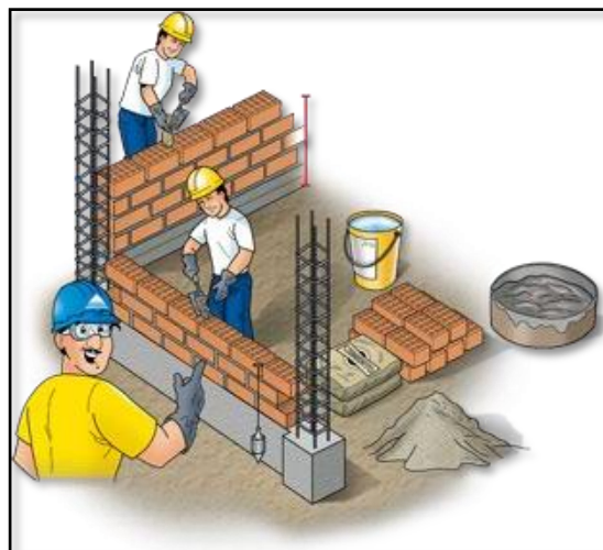
Gráfico 6: Construcción de muro de albañilería confinada.
