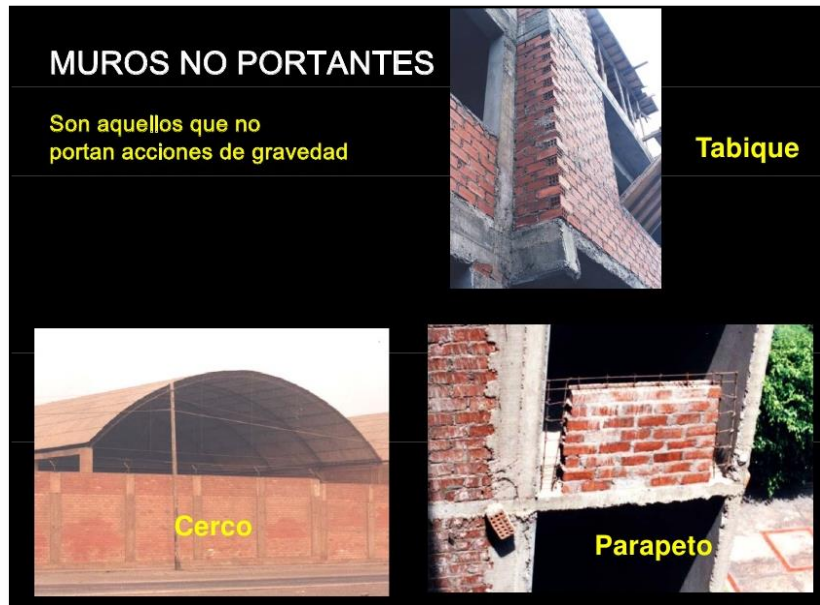
Gráfico 9: Ejemplos de muros no portantes.
