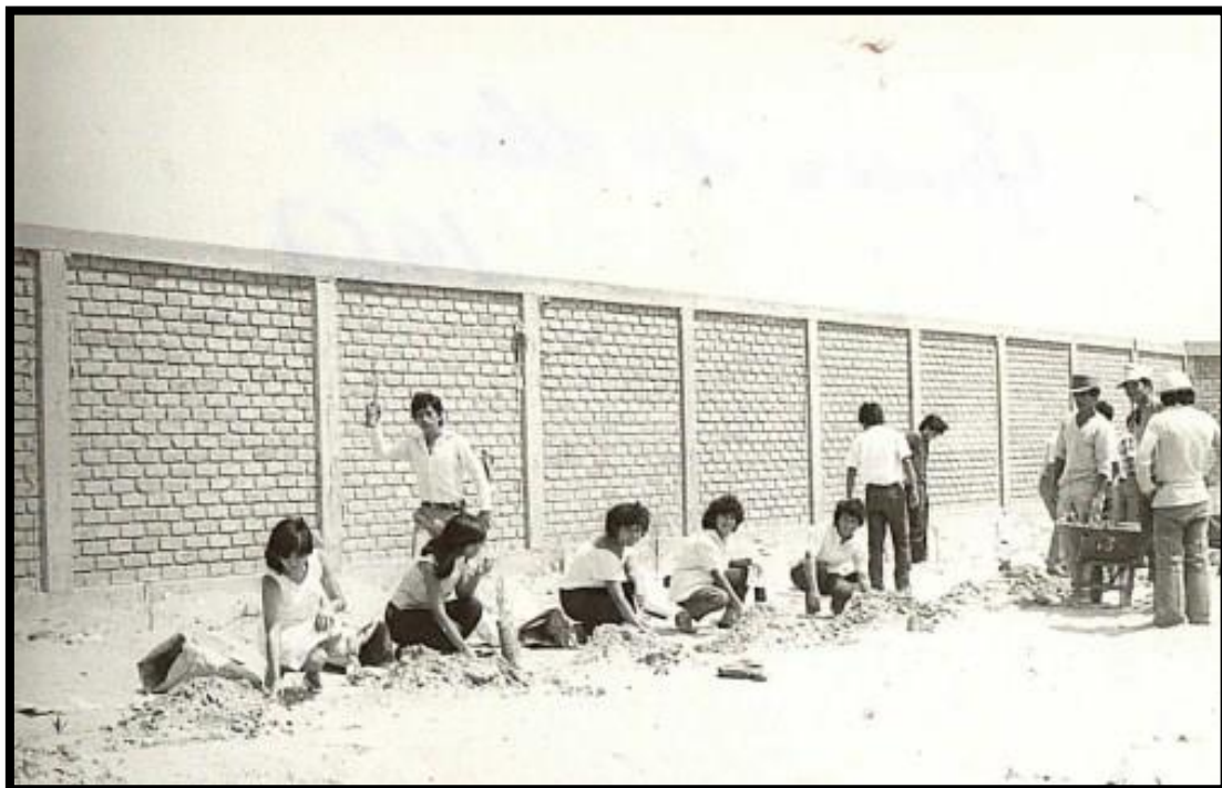
Fotografía n° 04. Mantenimiento del cerco Perimétrico de la universidad nacional del Santa a cargo del mismo alumnado de dicha Institución.
