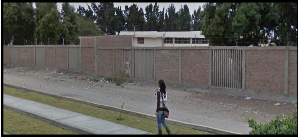
Fotografía n° 07. Vista panorámica del Tramo N° 16 parte posterior de la Universidad Nacional del santa
