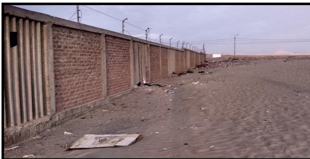
Fotografía n° 07. Vista panorámica del Tramo N° 06 parte posterior de la Universidad Nacional del santa
