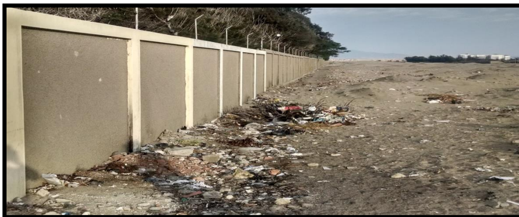
Fotografía n° 07. Vista panorámica del Tramo N° 24 parte posterior de la Universidad Nacional del santa
