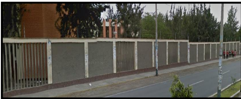
Fotografía n° 07. Vista panorámica del Tramo N° 23 parte posterior de la Universidad Nacional del santa
