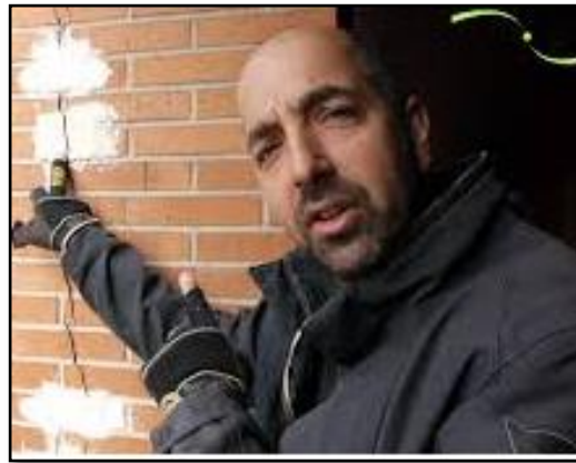
Gráfico 17: Fisuras en muro.
