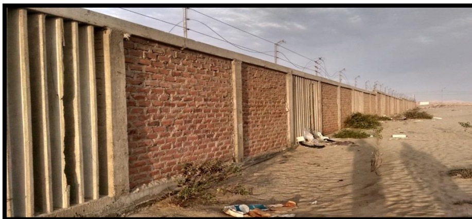
Fotografía n° 06. Vista panorámica del Tramo N° 02 parte posterior de la Universidad Nacional del santa.
