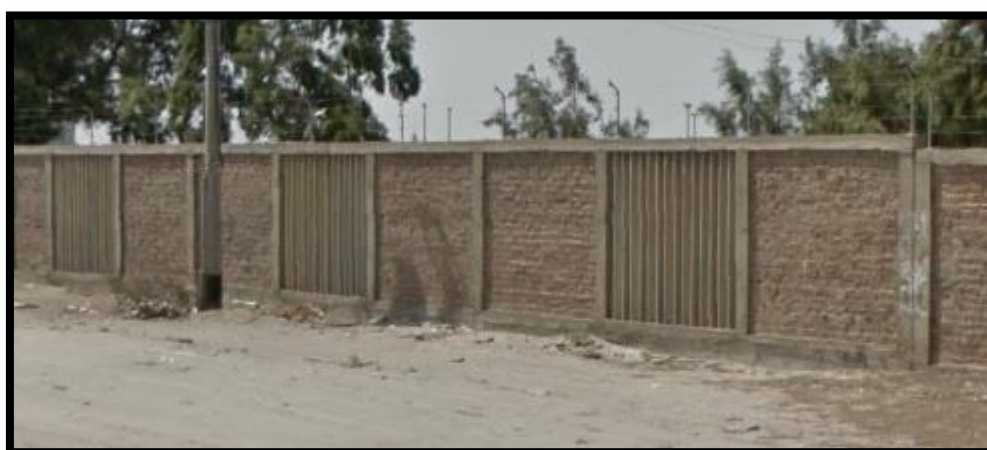
Fotografía n° 07. Vista panorámica del Tramo N° 09 parte posterior de la Universidad Nacional del santa
