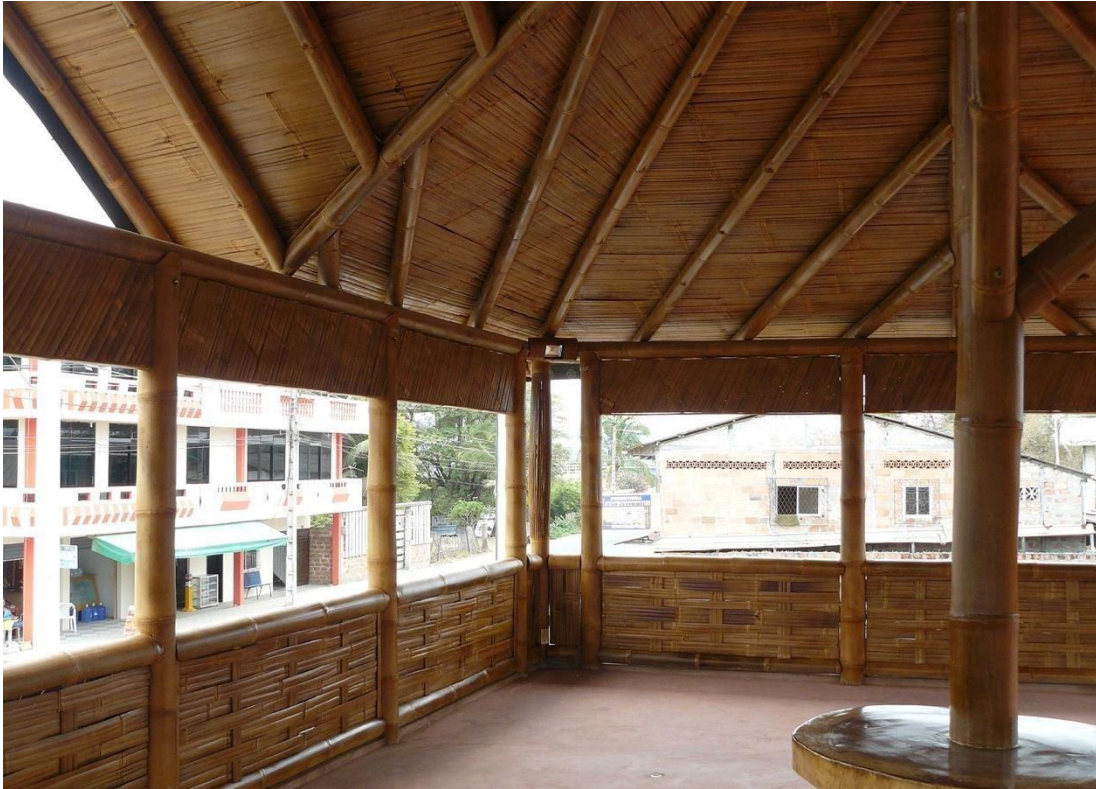
Caña de Guayaquil usado en la construcción de Edificaciones
