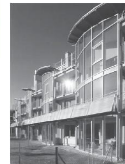
Edificio Residencial Hofjägerstrasse, Viena Austria. Fotografía de Rupert Steiner. En: Georg W. Reinberg, Solar architecture. Casa Ed. Libria, Melit, Italia, Segunda Edición, Septiembre 2006, p. 55.
