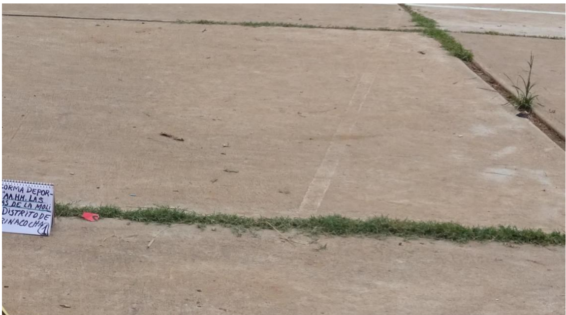
Figura N° 06 Se puede observar la presencia de la falla de Losa dividida en la plataforma deportiva del AA .HH Las lomas de la Molina
