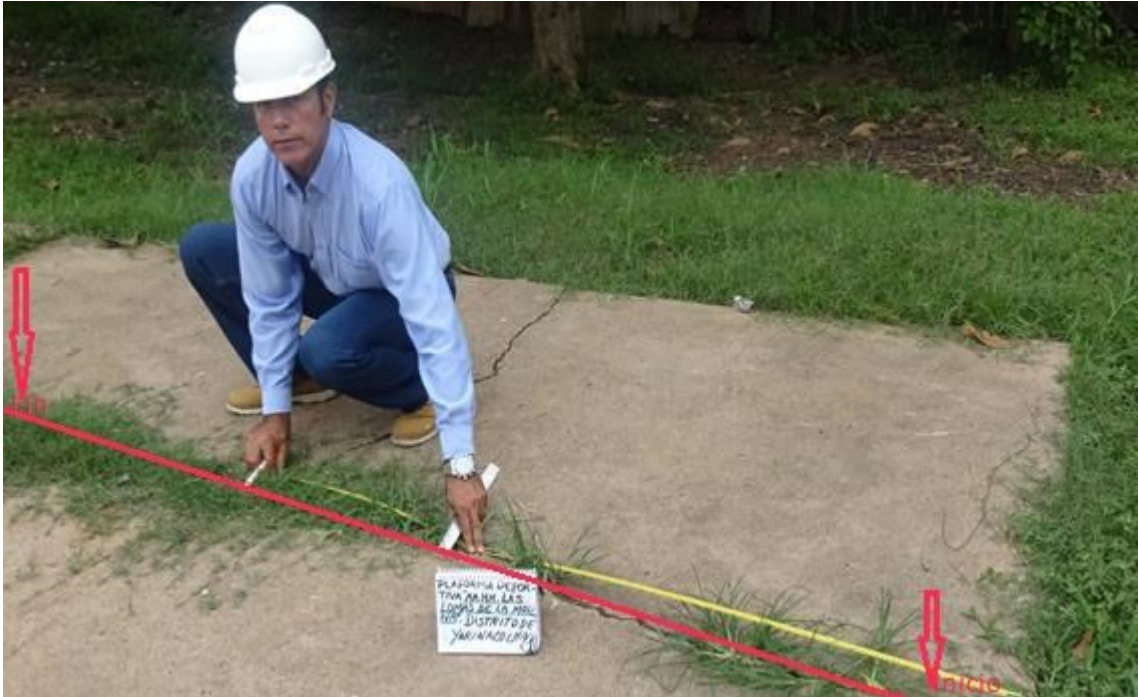
Figura N° 06 Se puede observar la presencia de la falla de Losa dividida en la plataforma deportiva del AA .HH Las lomas de la Molina
