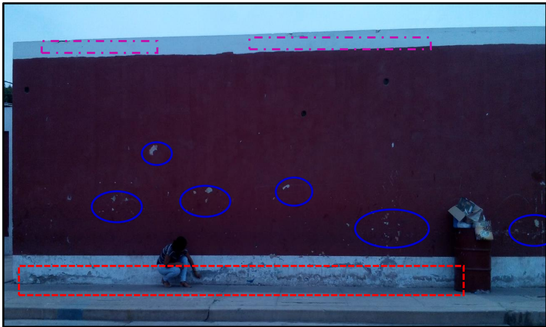
Fotografía 06- Unidad muestral 7 del pabellón F de la Institución Educativa “Republica Peruana”.
