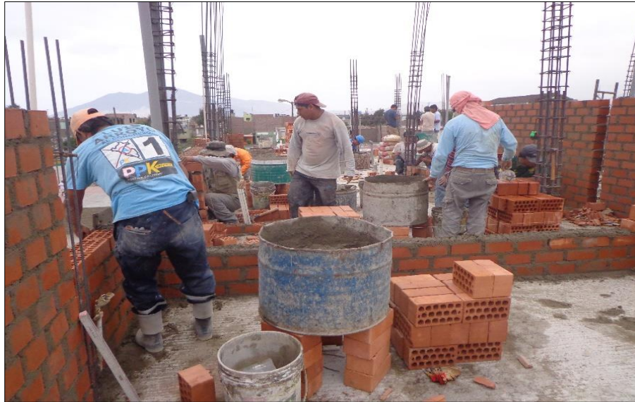
Figura 03: Elementos de acero reforzado en una vivienda.
