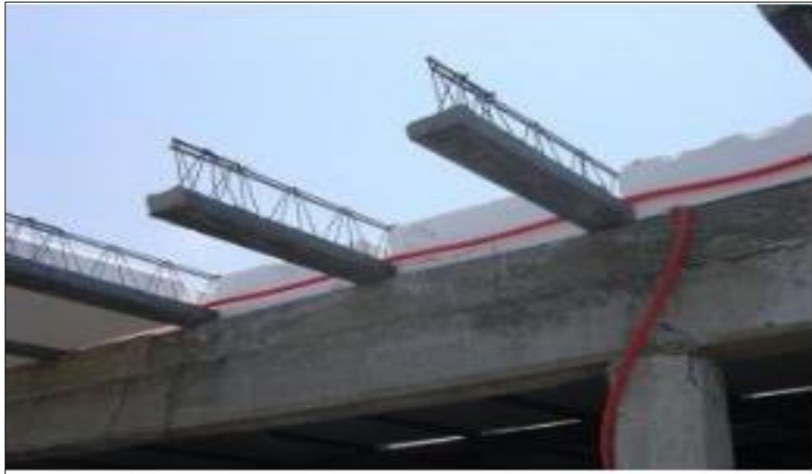
Figura 05: Viga de concreto armado para una institución Educativa.
