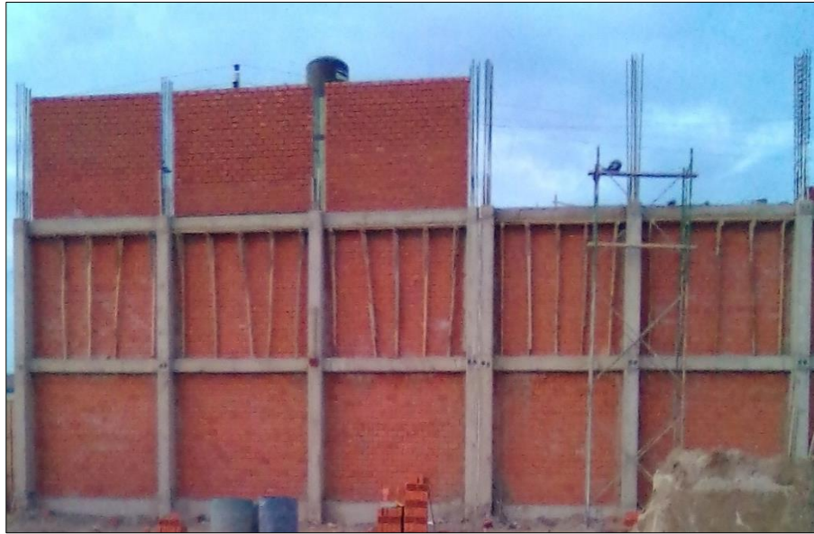
Figura 01: Fotografía de albañilería Confinada del cerco perimétrico
