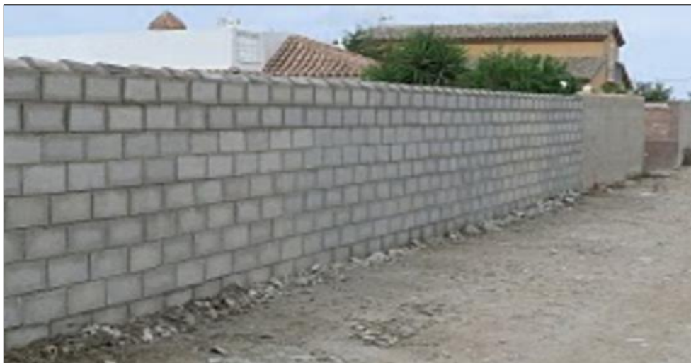
Figura 02: Albañilería simple de un cerco perimetral
