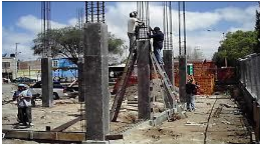
Figura 04: Construcción de columnas de concreto armado para una institución Educativa.
