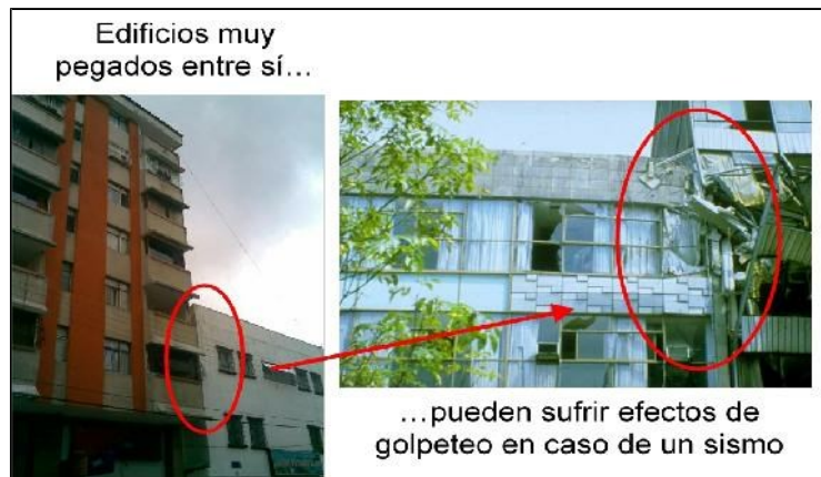
Figura 59, Imagen sin juntas entre edificios
