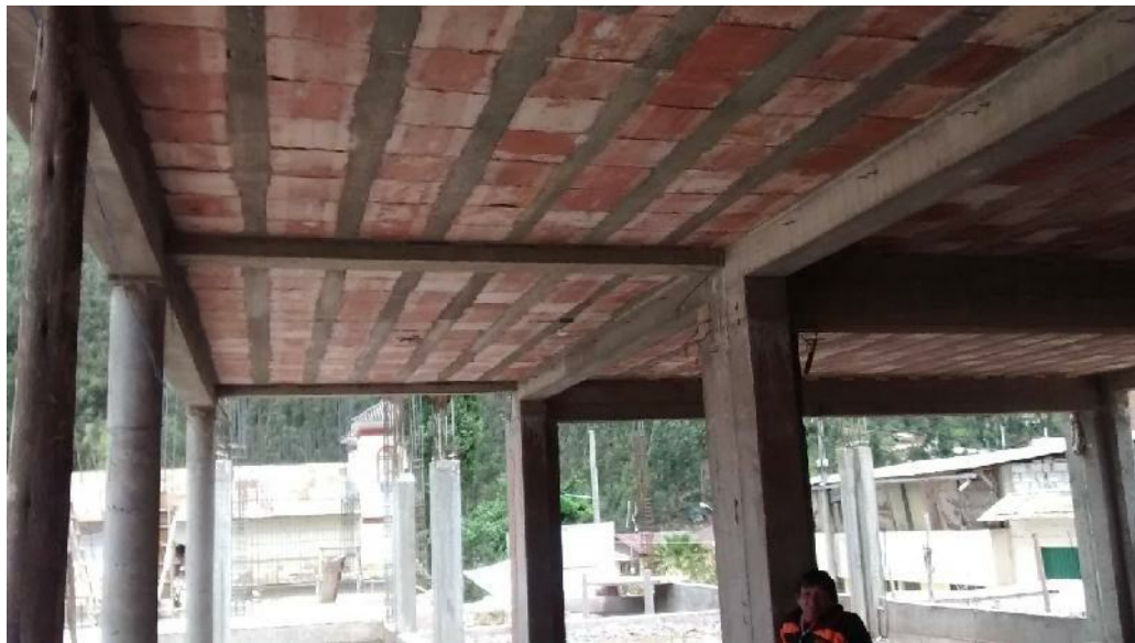
Figura 155. Vista del cambio de peralte de la viga principal
