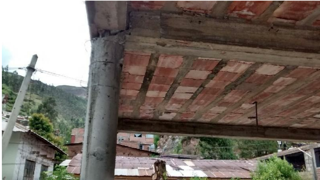
Figura 152. Unión entre columnas y vigas
