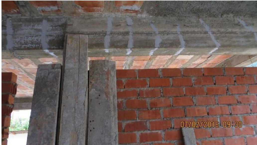
Figura 154. Vista de la viga principal
