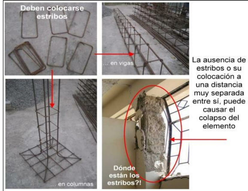
Figura 39, Patologías por mal proceso constructivo
