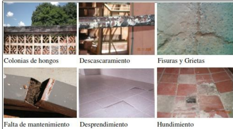
Figura 35, Ejemplo de patologías de acabados o lesiones menores (02)
