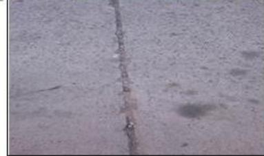
**Figura 17.** Daño de Sello de Junta en la Unidad Muestral UM-1.
