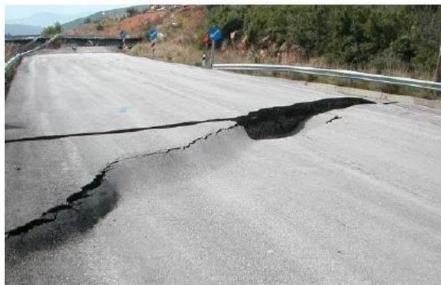
*Figura 9 Gráfico de falla estructural de pavimento.*
