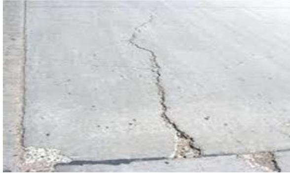
*Figura 10 Gráfico de falla superficial de pavimento rígido.*
