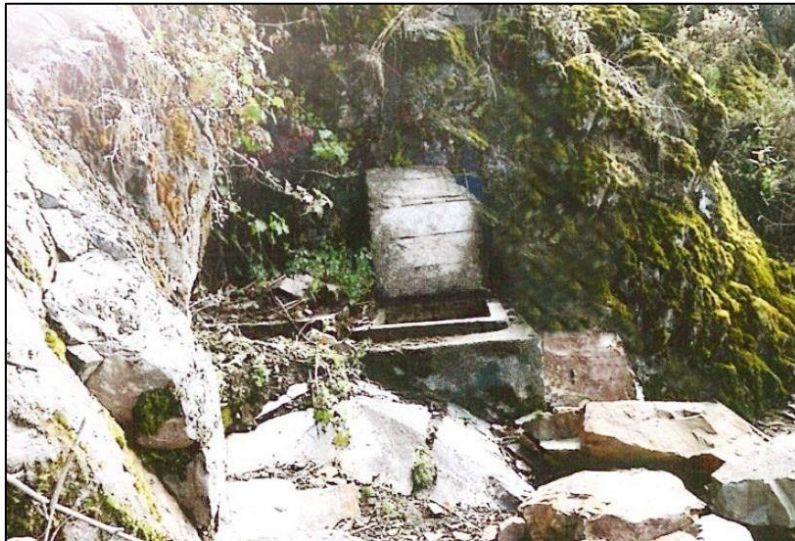
Imágen 6 Obra de captación por manantial tipo ladera
