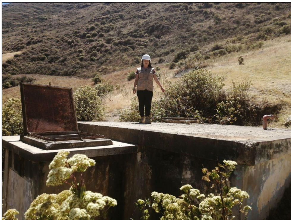
Imágen 8 Reservorio de almacenamiento de agua potable
