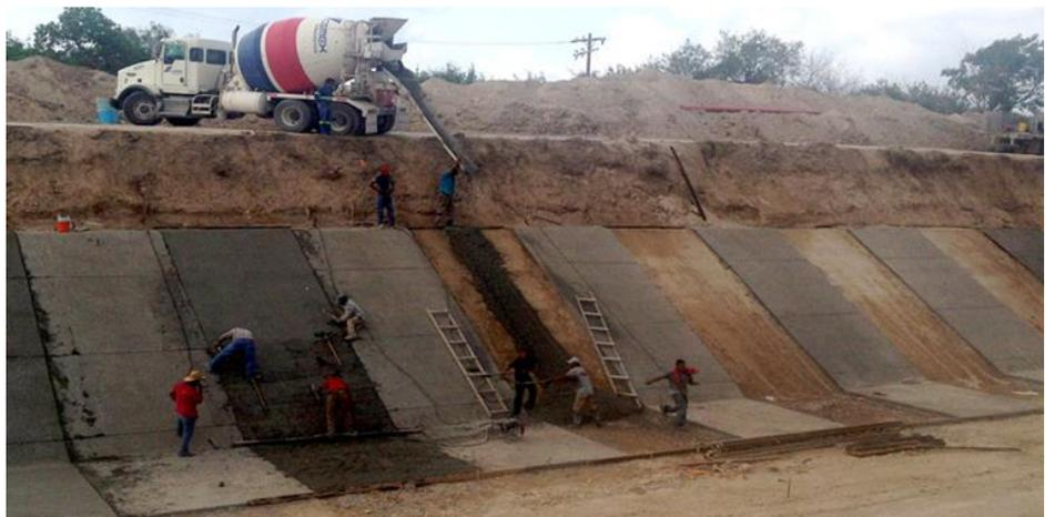
*Figura 5. Vaciado de concreto en un canal*
