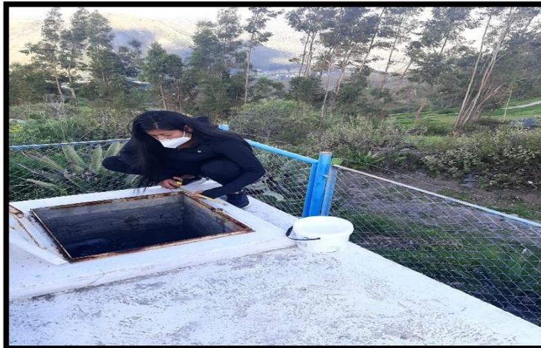
**Reservorio de 10 m<sup>3</sup>, verificación de la oxidación del marco de la tapa sanitaria de la cámara húmeda.**
