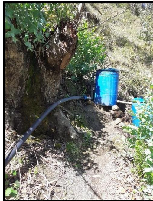
Conexión del hdpe hasta los filtros
