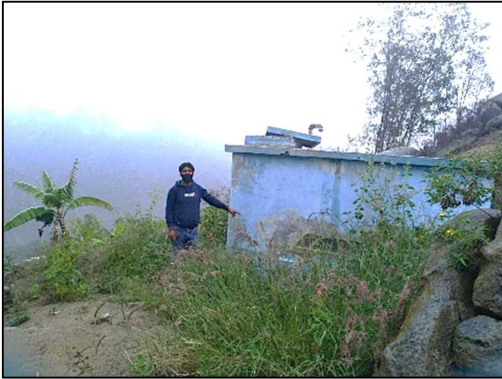
Figura N° 24: Reservorio del proyecto
