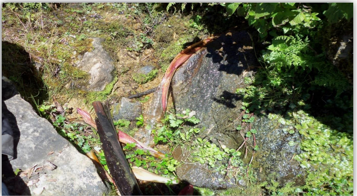
Fotografía 02: Ubicación de la captación de ladera
