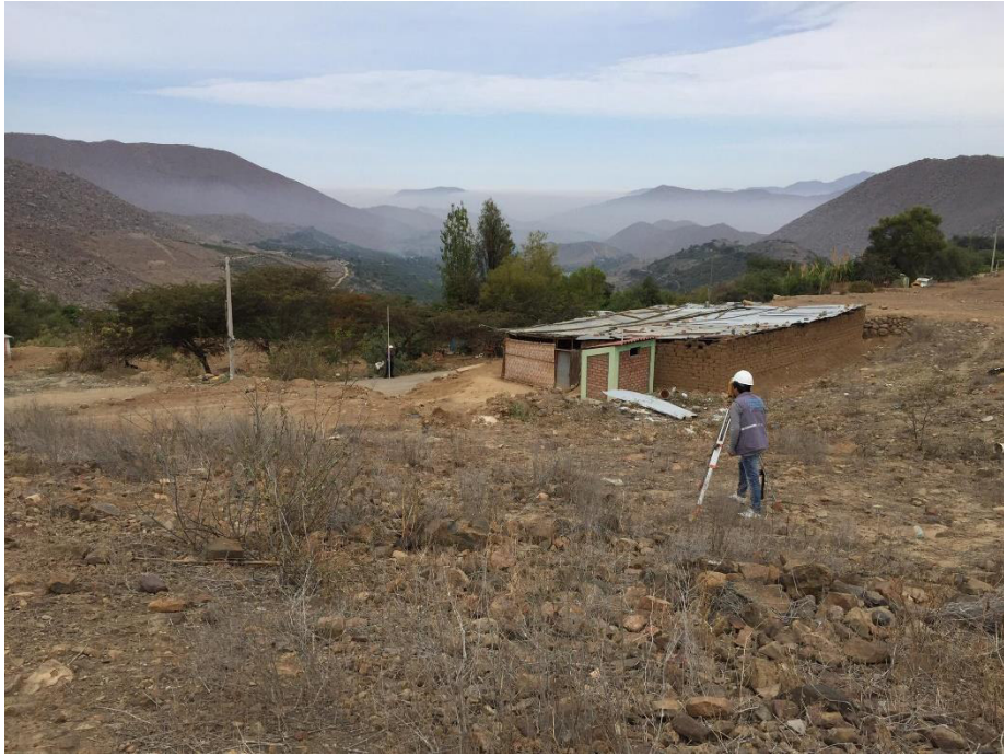
Fotografía 03: Levantamiento topográfico línea de aducción
