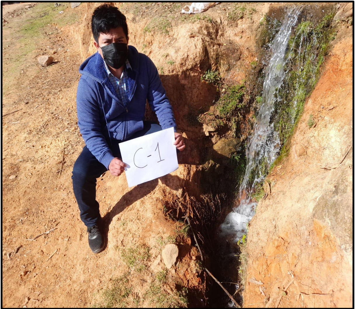
Fotografía 5: Ubicación de la calicata N° 1 para la cámara de captación.
