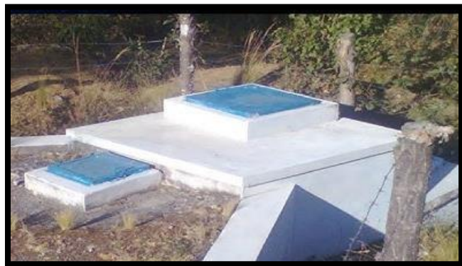
Figura 9. Obra de captación por manantial tipo ladera Fuente: Wikipedia
