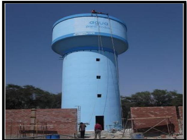
Figura 13. Fuente: KIBE Construcciones
